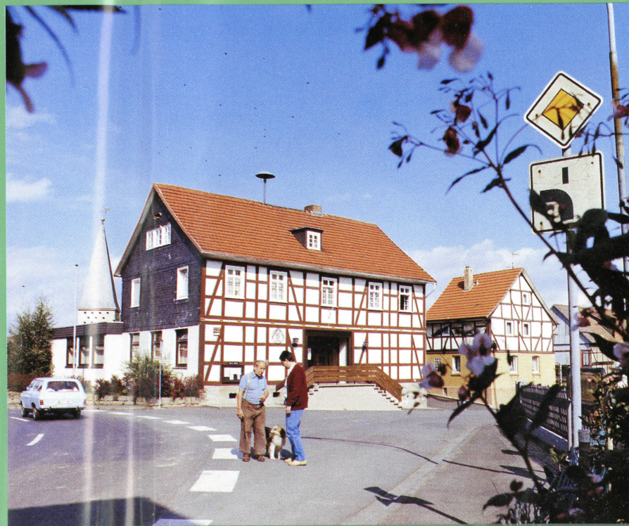
Ansicht OT Mosheim mit Dorfgemeinschaftshaus
