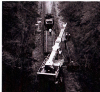
Rückbau der Gleise beim Südportal des Oberbeisheimer Tunnels 1982
