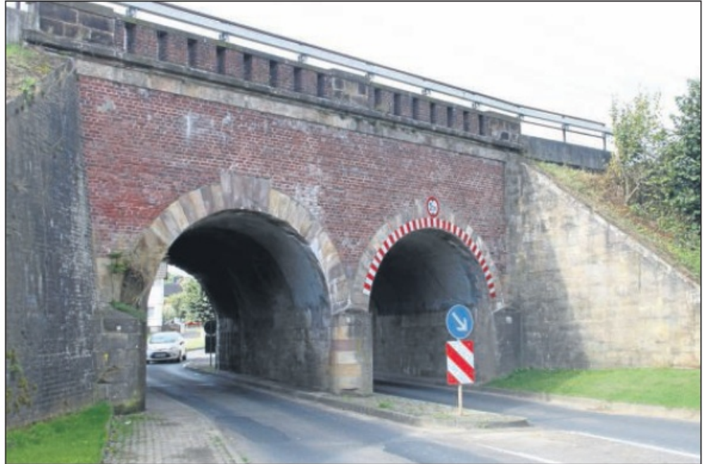
Dort werden die Reisenden ein- und aussteigen: Die Haltestelle der Bahn soll verlegt werden. Sie wird direkt hinter den Viadukten an der Lindenstraße in Richtung Beiseförth entstehen. Foto: Nolte
