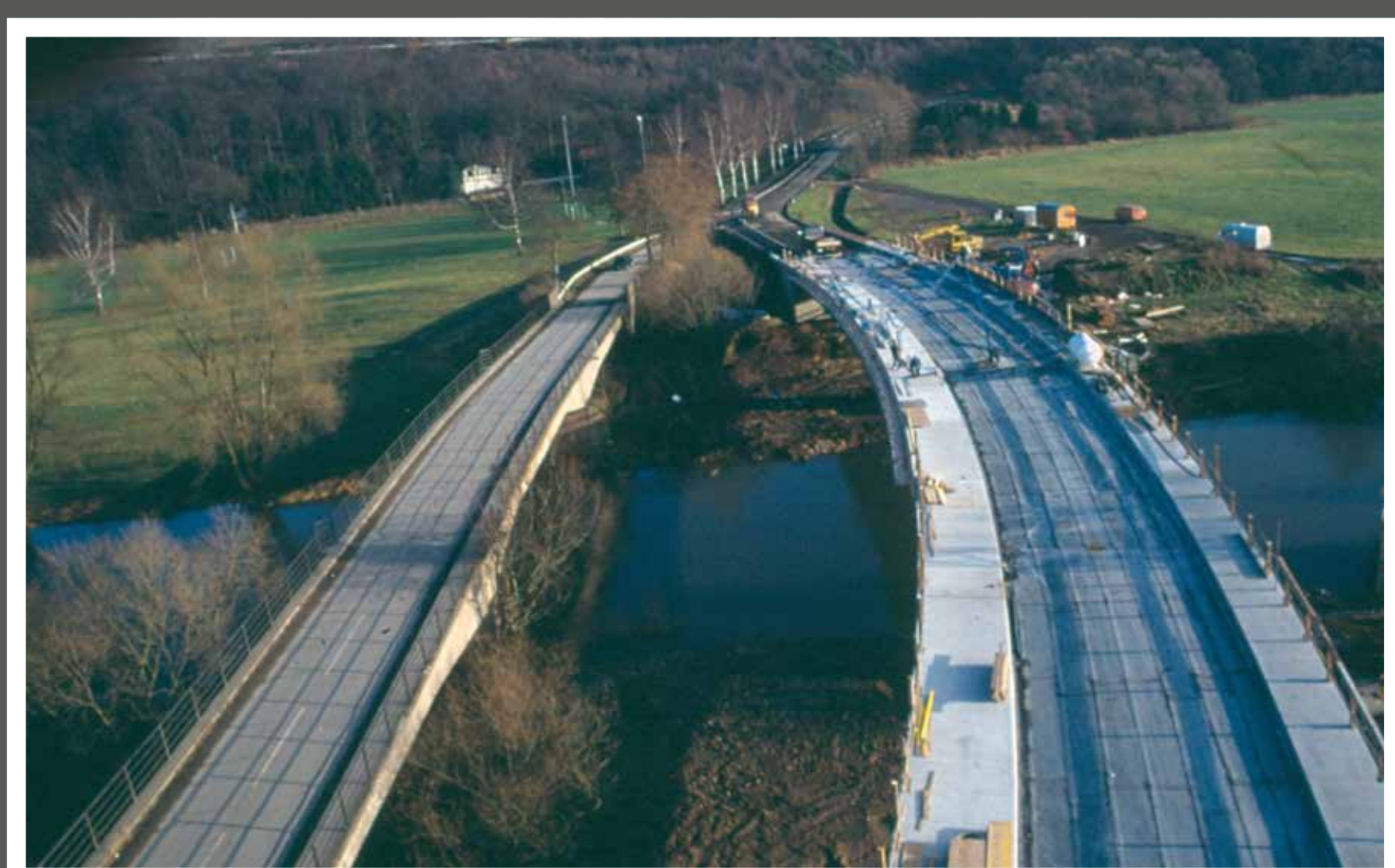
Links die Brücke von 1933, rechts die heutige von 1993.
