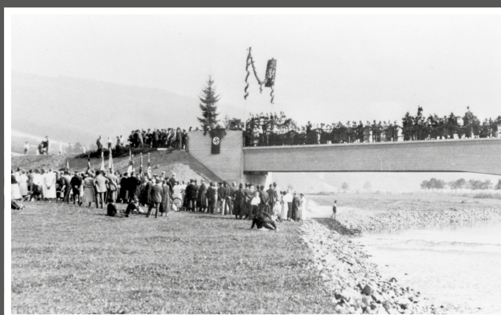
Betonbrücke von 1933: Tragfähigkeit 16 t.
