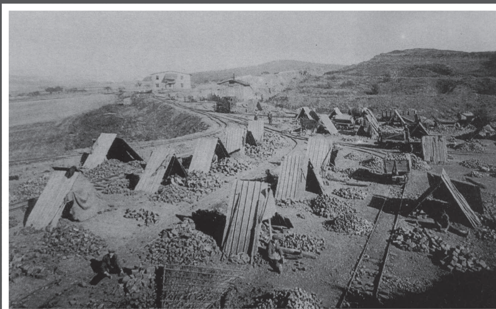
Etwa 1950: in Steinrichterhütten wurden Pflastersteine „geklopft“.
