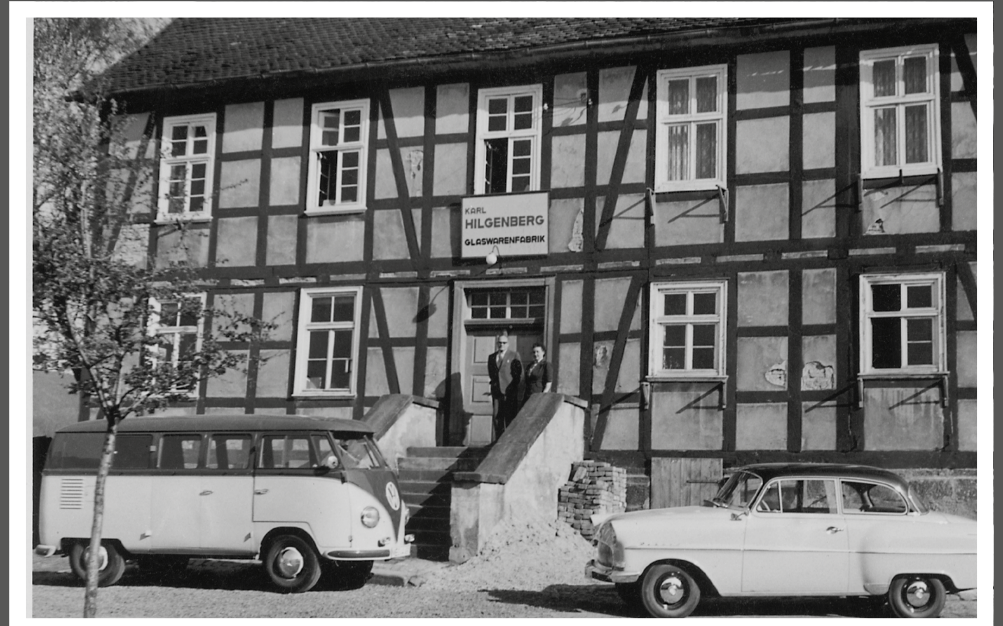
Das Schulgebäude wurde später an die Glaswarenfabrik Karl Hilgenberg (heutige Hilgenberg GmbH) verkauft. Nach dem Abriss 1977 blieb nur der Gründungsstein erhalten.
