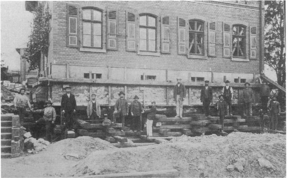
Umsetzung des kompletten, ehemaligen Bahnmeisterhauses wegen Bau der sog. Hochbahn (Verbindung zwischen den Bahnstrecken Kassel-Bebra und Eschwege - Treysa) um 1905, von einer Straßenseite zur anderen (heute Haus Waskönig) Siehe auch folgende Bilder
