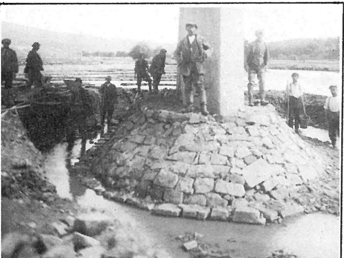
War der Bau der Vorgängerin noch recht mühsam (Foto vom 22.6.1934)...
