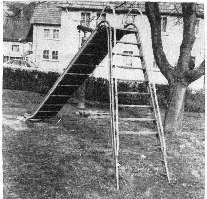
3 Stufen fehlen an der Leiter...
