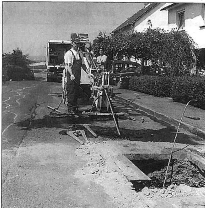
Die - egm - hat mit den Bauarbeiten zur Erdgaserschließung von Ostheim begonnen. Hier zwei Mitarbeiter der Firma Leitungsbau- und Bohrtechnik Zwickau GmbH, Anatoli Vogel und Sergej Galjard, beim Spülbohren in der Blumenstraße.
