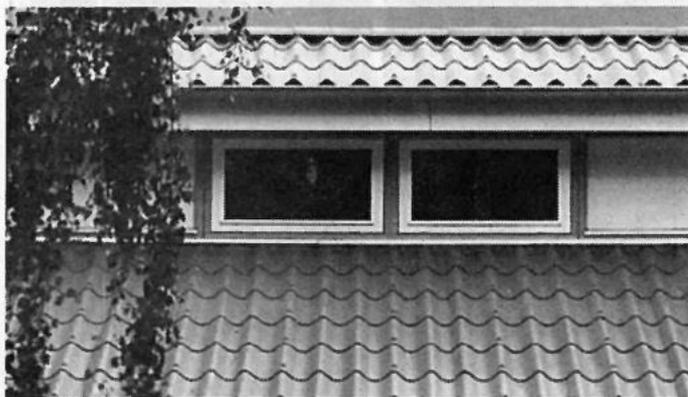
(wnp). Der Phantasie des Bauherren sind keine Grenzen gesetzt – mit den Kurzwellplatten EurocemWelle Profil 7 können alle Vorstellungen einer zeitgemäßen Dachgestaltung verwirklicht werden. Die Platten aus asbestfreiem Faserzement sind dabei äußerst wirtschaftlich, da sie einfach und schnell zu verarbeiten sind. So kann eine dauerhaft zuverlässige Eindeckung geschaffen werden, die zudem sehr kostengünstig für eine besonders ästhetische Strukturierung jeder Dachfläche sorgt.
