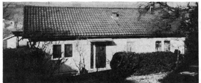
Auch optisch tut diesem Haus das neue Dachgeschoß (siehe oben) gut. Fotos: Schwäbisch Hall/HP
