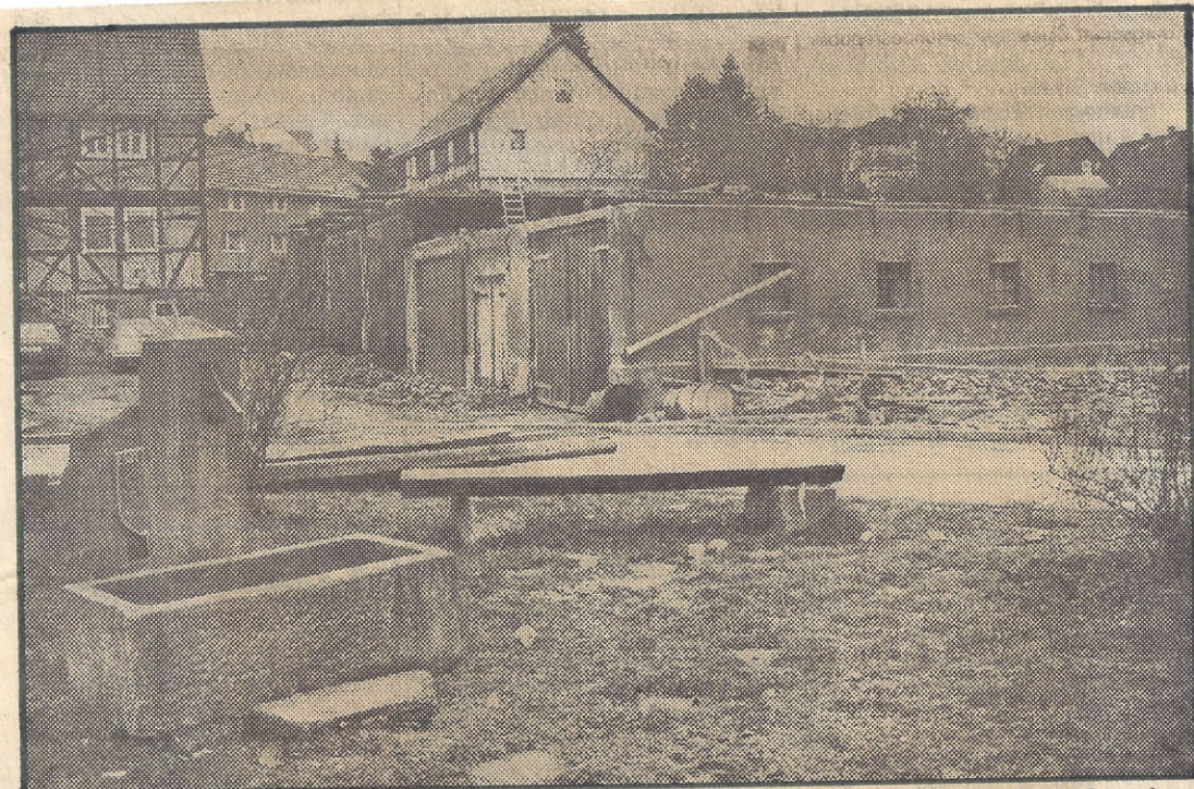
EINE EINZIGE BAUSTELLE ist derzeit das künftige Gemeindezentrum in Malsfeld (die HNA berichtete bereits mehrfach über das Projekt). Junge Leute ohne Lehrstelle, die im Kreis vom Verein „Starthilfe“ betreut werden, haben bereits das Fachwerk der einstigen Scheune (rechts) abgetragen, das dann wieder aufgebaut werden soll. (Foto: hro)
