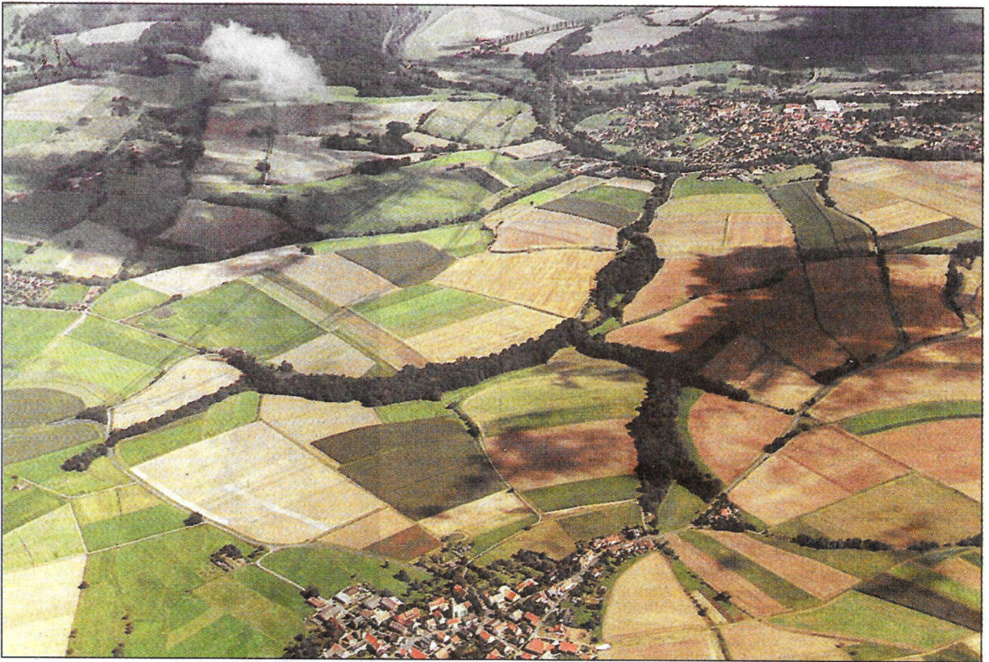
Vorbei an Dagobertshausen wird die neue Kreisstraße zwischen Malsfeld (rechts im Bild) und Elfershausen (links) verlaufen, die als Autobahnzubringer eine Verbindung zwischen der Bundesstraße B 83 und dem Hochland darstellt. Mittels einer Überführung muß die Kreisstraße 135 zwischen Elfershausen und der Kerngemeinde überquert werden. (Foto: Zweckverband)
