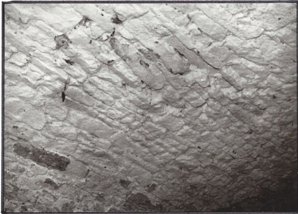
Kellergewölbe noch von der Burg um 1615
