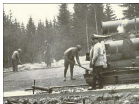
Abwalzen hinter dem Fertiger: Für den Straßenbelag wurde unter anderem Asphalt-Teerbeton verbaut. Das Bild entstand am 14. April 1937 in Höhe des Humboldtsblick rund zwei Kilometer südlich der Werratalbrücke.
