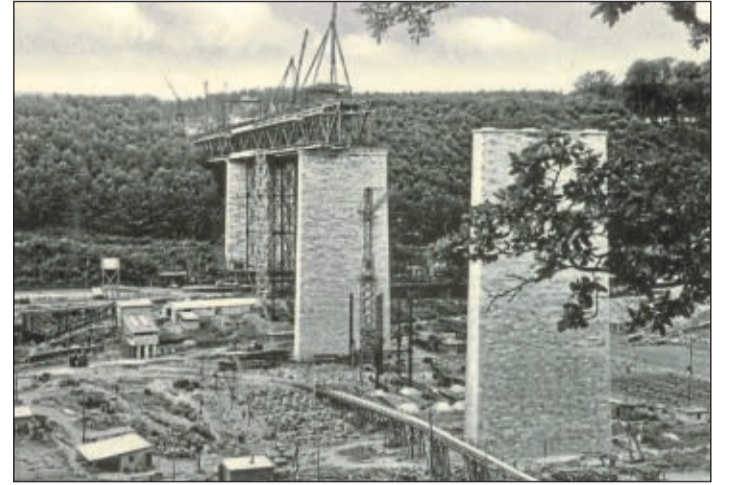
Wunderwerk der Bautechnik: In nur 20 Monaten wurde die 416 Meter lange und 61 Meter hohe Werratalbrücke erbaut. Sie war die Schlüsselstelle für den A7-Streckenabschnitt Kassel-Göttingen.
