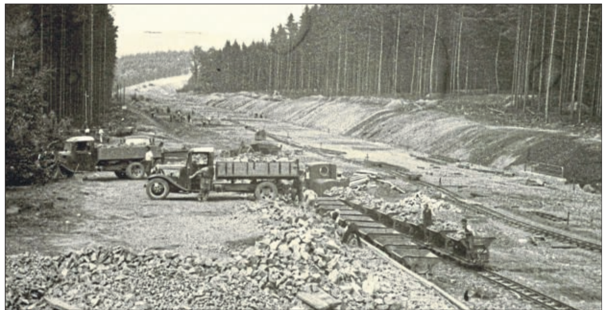
Das meiste war Handarbeit: Nie zuvor wurden die Aufnahmen von Heinrich Konrad, dem damaligen Bauführer für den A7-Abschnitt Kassel-Göttingen (zuständig für die Fahrbahndecken) veröffentlicht. Das Bild oben zeigt Arbeiter beim Bau der A7-Trasse mitten im Kaufunger Wald mit Blick nach Norden etwa zwei Kilometer nördlich des Rinderstalls am 27. Juli 1936.
