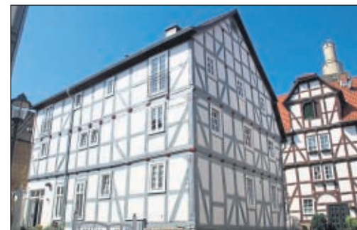
Ein Schmuckstück in der Felsberger Altstadt, gefördert vom Land Hessen und der EU: Die ehemalige Bäckerei Schultze wurde vor dem Verfall gerettet. In dem Fachwerkhaus entstanden ein Café, Ferienwohnungen und Büros.
