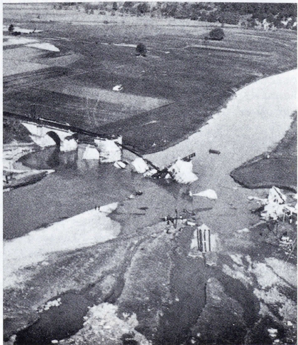
Vom Hochwasser zerstörte Brücke im Edertal, 17.5. 1943
