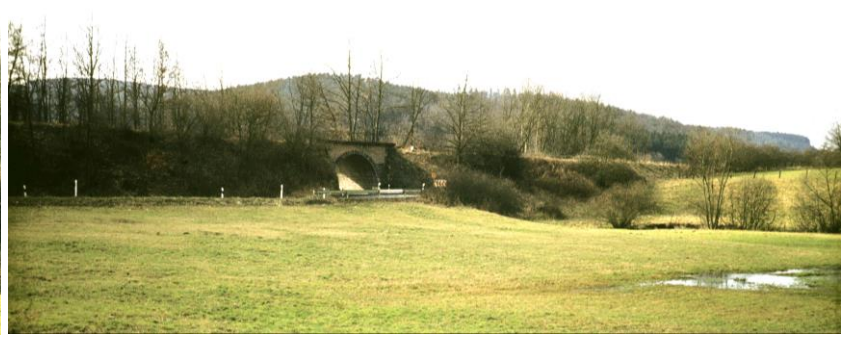
Die Vockebrücke an der Nordseite mit der Straße nach Bischofferode (Foto: R. Salzmann 1974)
