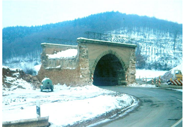
Die Südseite des Überbaues während des Abrisses im Jahre 1978 (Foto: J. Kern, Sammlung Reinhold Salzmann)
