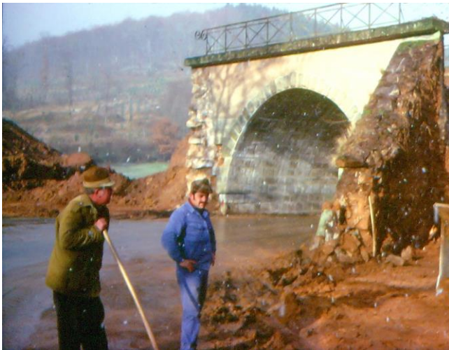
Der Damm zum Überbau wird gerade abgetragen, während eine der Stützmauern noch vorhanden ist. (Foto: Sammlung Jürgen Kern)
