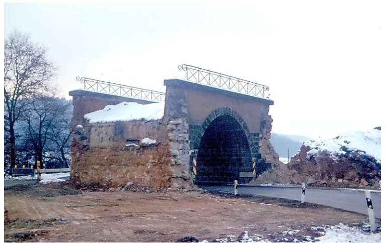
Der Oberbau der Brücke steht noch, die Dämme sind aber bereits abgetragen.
