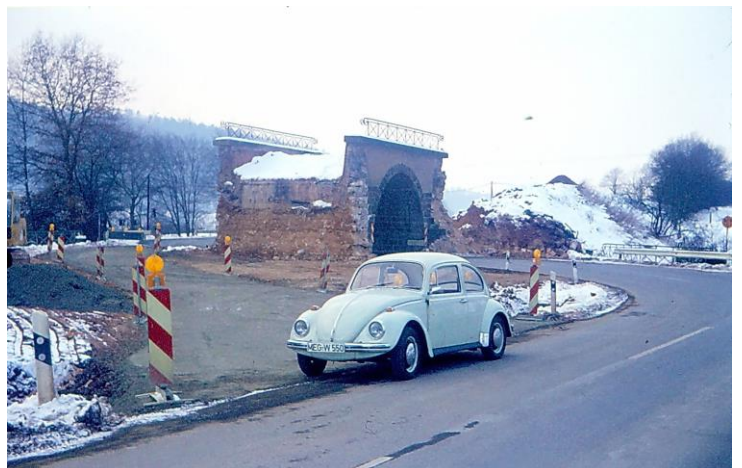
Die Nordseite vom Überbau in der Abrissphase im Winter 1978. Die seitlichen Stützmauern sind schon verschwunden, aber der hintere Teil des Dammes ist noch zu sehen, aber eine Behelfsstraße für den fließenden Verkehr wurde bereits angelegt. (Foto: Jürgen Kern, Sammlung Reinhold Salzmann)
