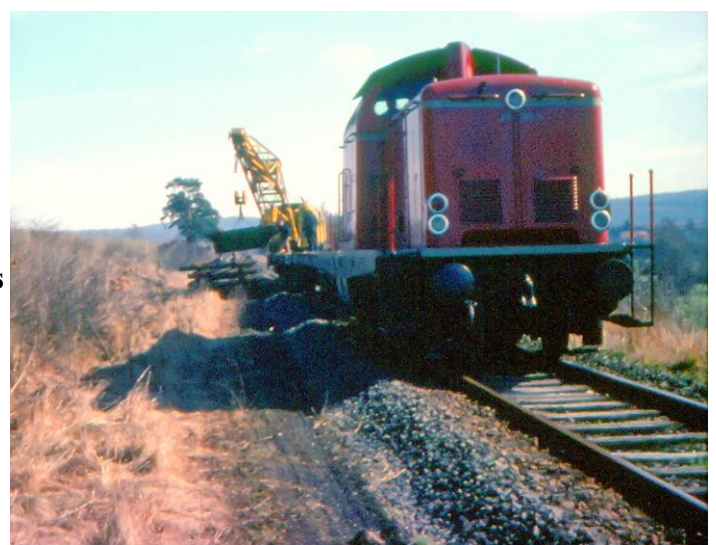
Der Abbauzug reißt hinter dem anhängenden Kranwagen die Gleisjoche aus dem Gleisbett, um sie daneben aufzustapeln. (Foto: J. Kern um 1977, Sammlung R. Salzmann)
