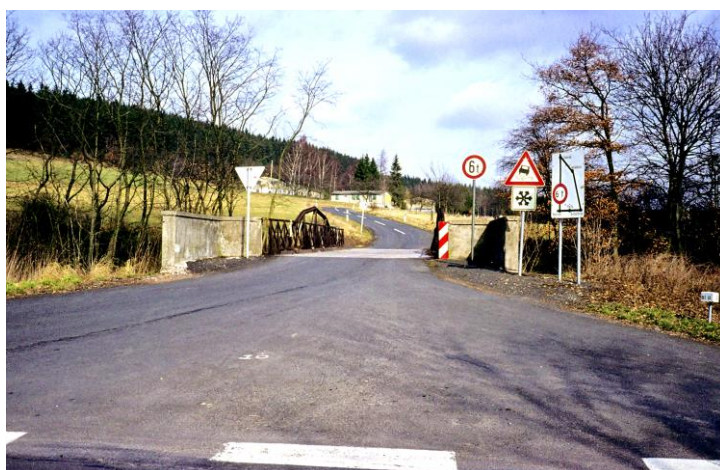
Die Brücke in Blickrichtung nach Vockerode-Dinkelsberg um 1978. Im Hintergrund ist das ehemalige Krankenhaus zu sehen, wegen dem der Haltepunkt Beieröde eingerichtet wurde. (Foto: Reinhold Salzmann)
