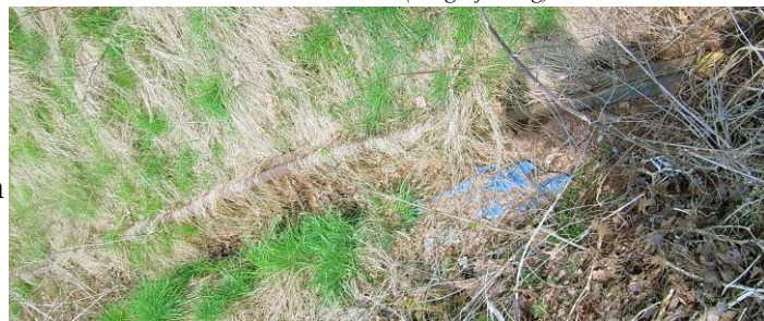
Das etwa 6 Meter lange Stück Schiene im Graben beim Wasserdurchlass am 9. April 2007.
