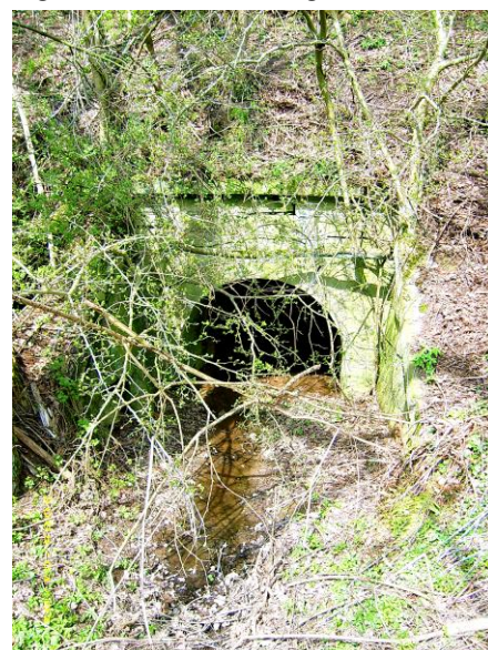
Der Ablauf des Durchlasses an der Südseite am gleichen Tag.
