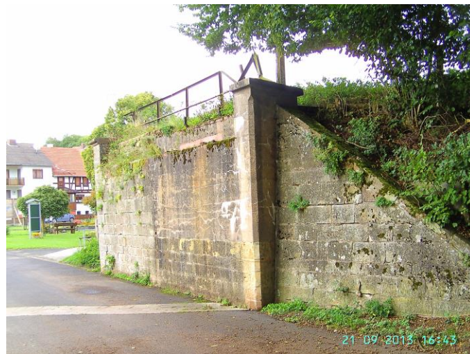
Die Südseite vom östlichen Widerlager am 21. 09. 2013.
