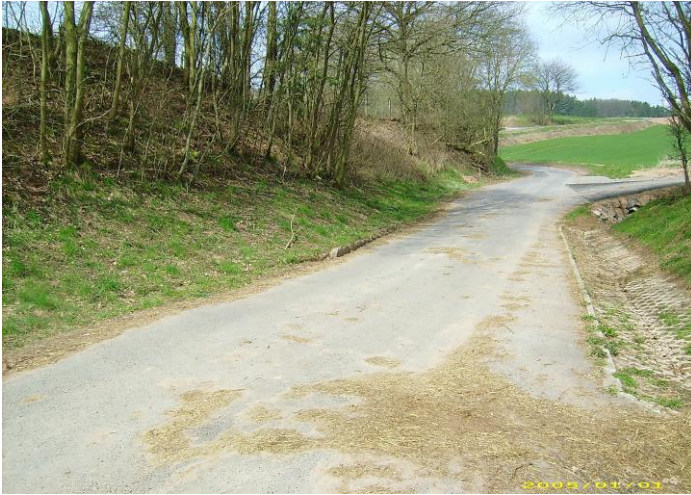
Der Feldweg am Km 74,469 kennzeichnet die Stelle, wo einst die Brücke gestanden hatte. (6. April 2007)
