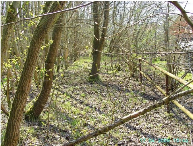
Der Bahnsteig und das Gelände der Stützmauer am 17. 04. 2008
