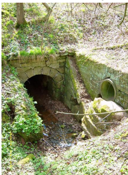
Die Nordseite vom Wasserdurchlass mit einem weiteren Einlauf am Km 73,174 am 10. 04. 2007.
