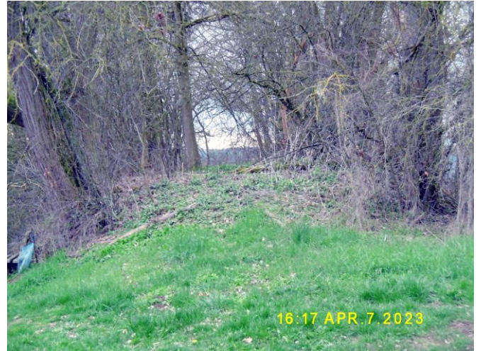
Die Trasse zwischen Km 74,469 und 74,9 etwa am Km 74,65. (Foto vom 7. April 2023)
