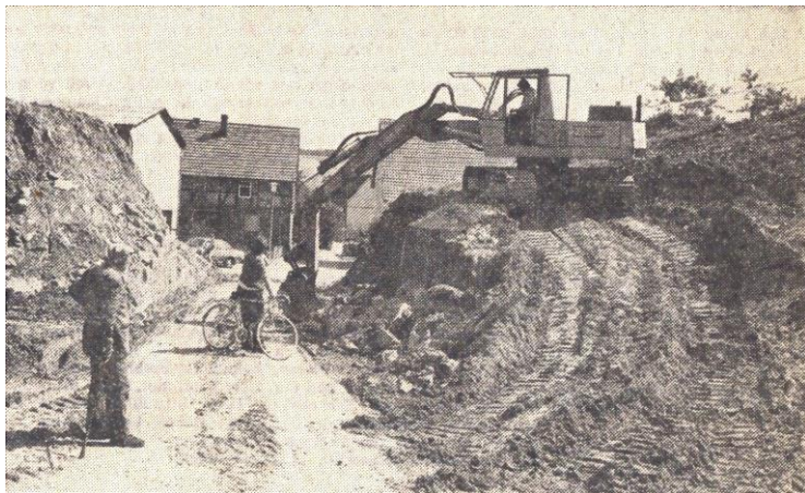
Das Bild aus der HNA vom 14. 6. 1980 zeigt etwa die gleiche Perspektive während der Abrissphase der Unterführung. (Foto: HNA, Sammlung Reinhold Salzmann)
