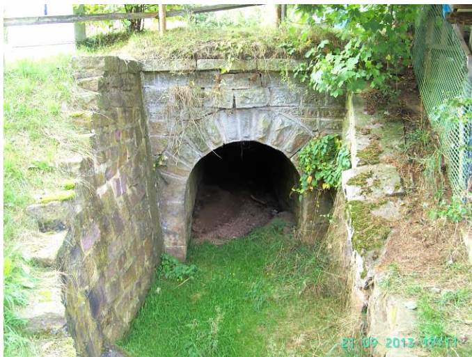
Das gesamte Südportal mit den seitlichen Stützmauern am 21. 09. 2013.
