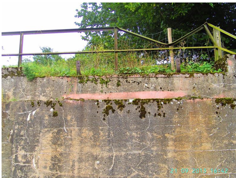
Der mit Beton ausgegossene Teil des Widerlagers am 21. 9. 2013.
