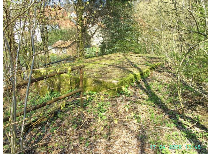
Die Grundmauer vom neuen Haltepunkt am 17. 04. 2008.
