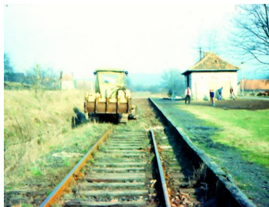
Das Gleis vor der Raupe am Haltepunkt Pfeiffe wartet noch auf den Abbauzug, der in Kürze den Rest der Strecke bis zum Haltepunkt Beieröde abbauen wird. Das Bild wurde von Westen her fotografiert. Der helle Querstrich links vom Stationsgebäude Pfeiffe im Hintergrund ist der Bahnübergang „Zur Schrecke“. (Foto: Jürgen Kern um 1977, Sammlung Reinhold Salzmann)
