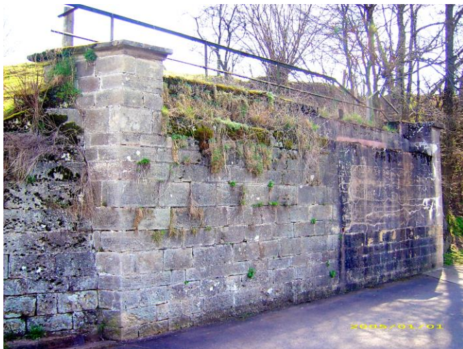
Die Nordseite des östlichen Widerlagers am 6. April 2007.
