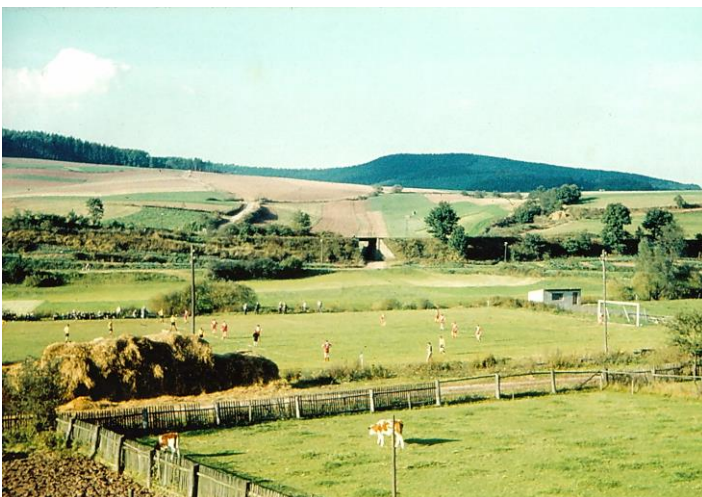
Die Bahntrasse mit der Brücke am Sportplatz am Km 74,469 kurz vor PfiEFFE. (Foto: Jürgen Kern, Sammlung Reinhold Salzmann)
