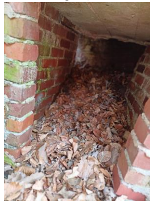
Ein Blick in den Schacht am 21. 4. 2023
