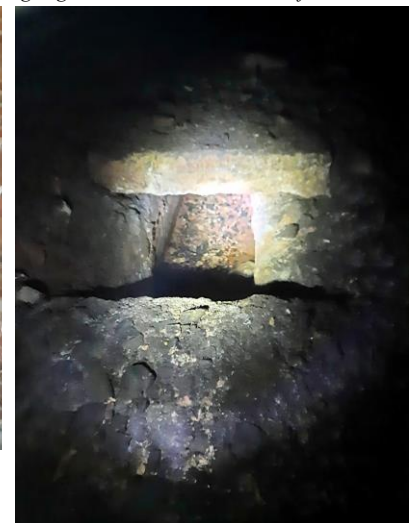
Ein trockenes Loch zum Abfließen von Wasser.
