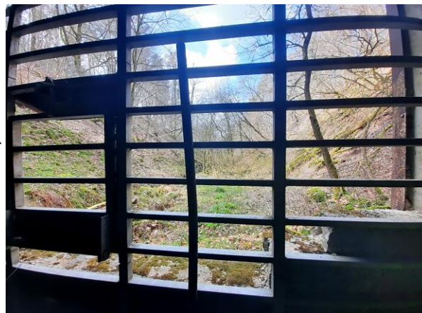
Ein Blick aus dem Westportal des Tunnels auf die Trasse am 26. 3. 2021.
