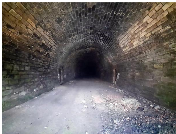
Ein weiterer Blick ins Innere des Tunnels am 26. 3. 2021.
