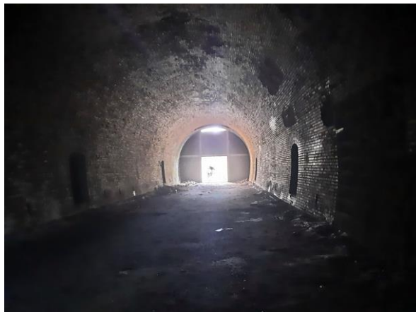
Blick aus dem Tunnelinneren in Richtung Ostportal am 26. 3. 2021.
