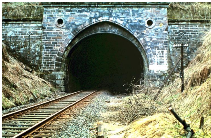
Das Ostportal vom Bischofferöder Tunnel im April 1974 (Foto: Volker Göbel)
