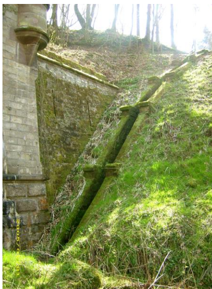
Der Bachlauf fließt kaskadenartig in der ge- mauerten Rinne den Hang hinunter und wird
