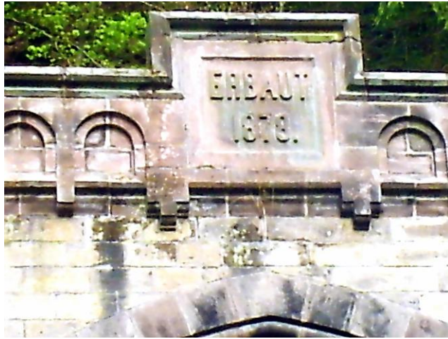
Die Jahreszahl 1878 im oberen Bereich des Westportals im Sommer 2004.
