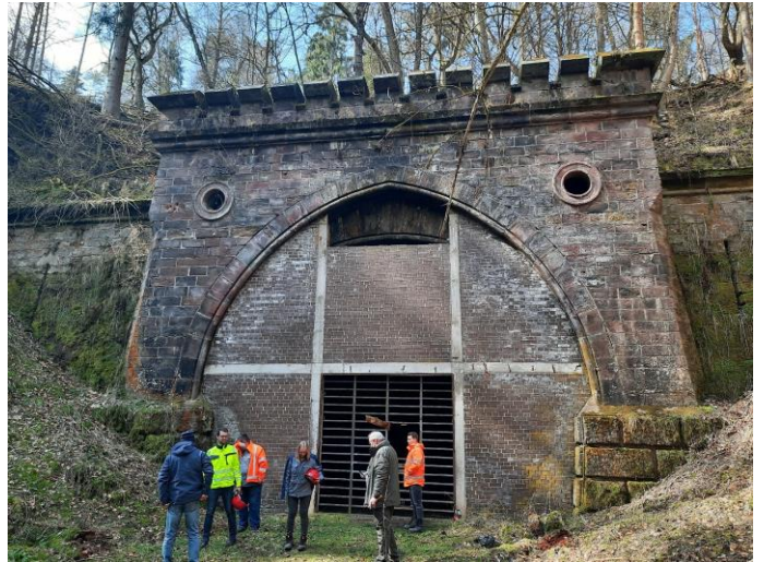
Treffen vor dem Ostportal zur Tunnelbesichtigung am 26. 3. 2021, (Foto: Jörg Schanze)
