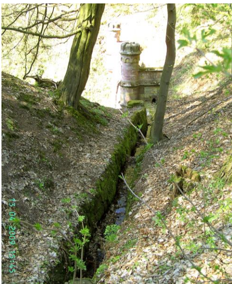
Der obere Teil des gemauerten Bachlaufs an der Südseite des Tunnels am 13. 4. 2009.
