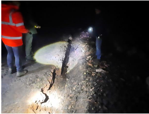
Trockener Wasser-Abflussgraben im Tunnel am 26. 3. 2021.
