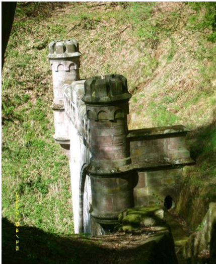
Der gemauerte Bachlauf an der Südseite des Tunnels von oben am 15. 4. 2007.
