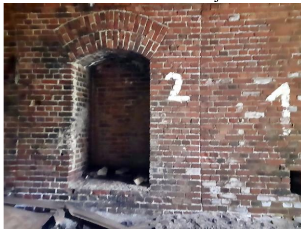
Eine der vielen Nischen zum Schutz für den Streckenläufer am 26. 3. 2021.
