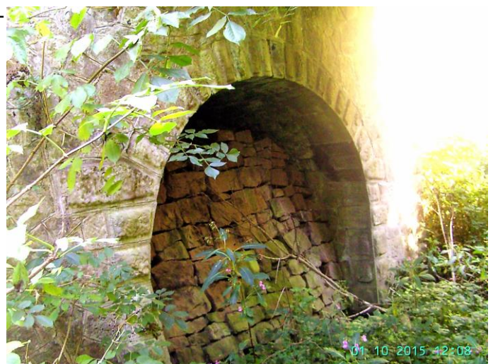
Der Bogen an der Frontseite des nördlichen Widerlagers. Die innere
