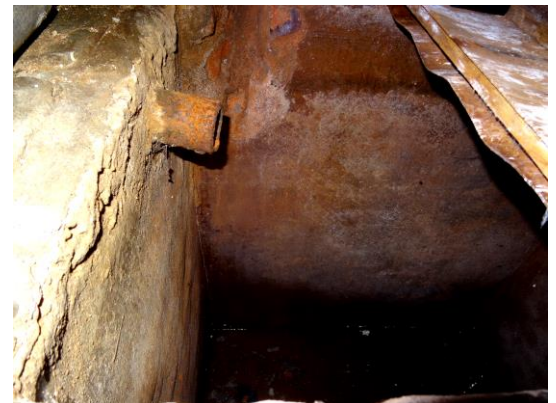
Der Vorratsbehälter für Frischwasser im Keller des Gebäudes, der Kellerraum mit (neuerer) Pumpe und ein Blick in den leeren Behälter (Fotos: Koch 2016)
