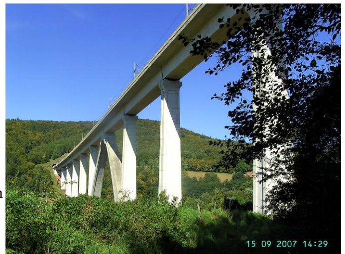
Die imposante Brücke der Neubaustrecke in der Mittagssonne am 15. September 2007.
