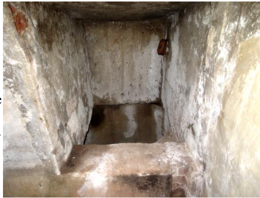
Das Innere der Brunnenkammer und das 2,40 m tiefe Brunnenrohr, das in einer Höhe von 1,40 m gefüllt ist.
