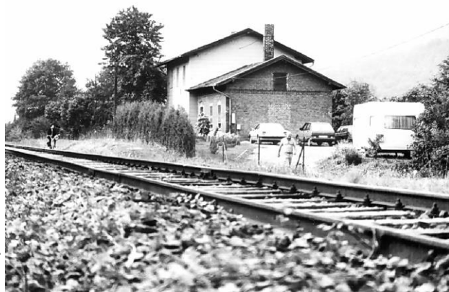
Als das Gleis noch lag, ein nutzloser Haltepunkt an der Strecke.
