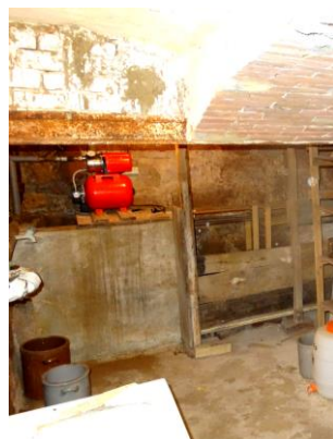
Der Vorratsbehälter für Frischwasser im Keller des Gebäudes, der Kellerraum mit (neuerer) Pumpe und ein Blick in den leeren Behälter (Fotos: Koch 2016)
