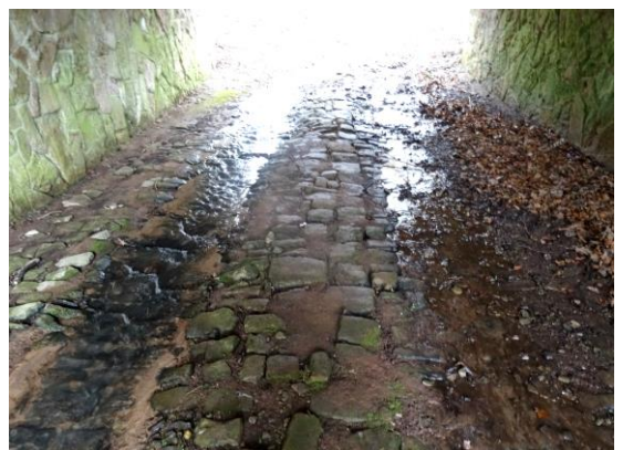
Das Kopfsteinpflaster unter der Gexbachbrücke von Norden
