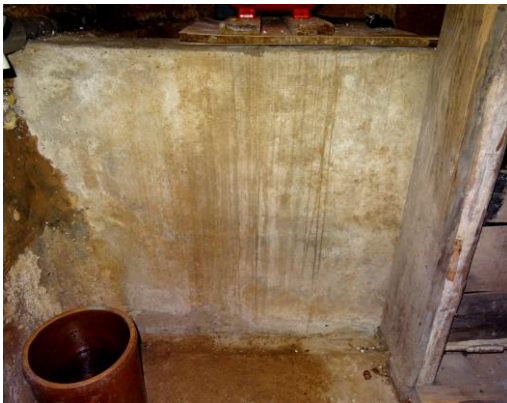
Der Vorratsbehälter für Frischwasser im Keller des Gebäudes, der Kellerraum mit (neuerer) Pumpe und ein Blick in den leeren Behälter (Fotos: Koch 2016)
