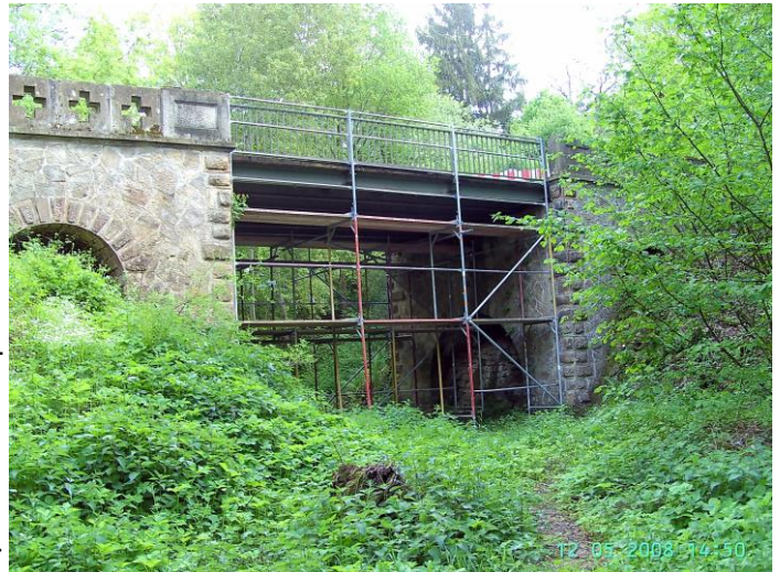
Die Wegeüberführung war während der Sanierung eingerüstet. (Foto vom 12. 5. 2008)
