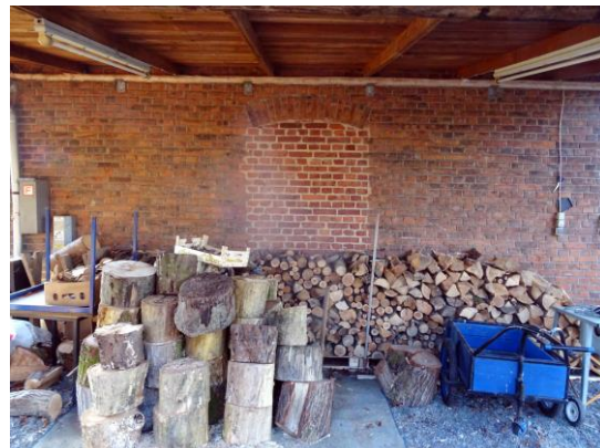
Der zugemauerte Eingang zum Warteraum an der Ostseite ebenfalls im Jahre 2016. (Beide Fotos: Heinrich Koch)
