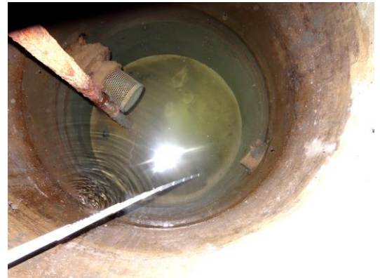
Das Innere der Brunnenkammer und das 2,40 m tiefe Brunnenrohr, das in einer Höhe von 1,40 m gefüllt ist.
