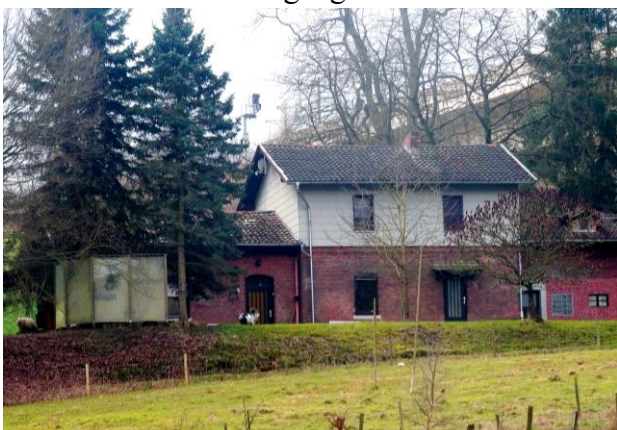
Die Nordostseite der alten Station Mörshausen mit der Eingangstür, die früher in den Warteraum führte (Foto: Heinrich Koch 2015)
