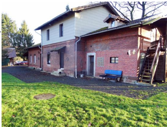
Ein Blick von Nordwesten auf den Toiletten- und Stallanbau im Frühjahr 2016.
