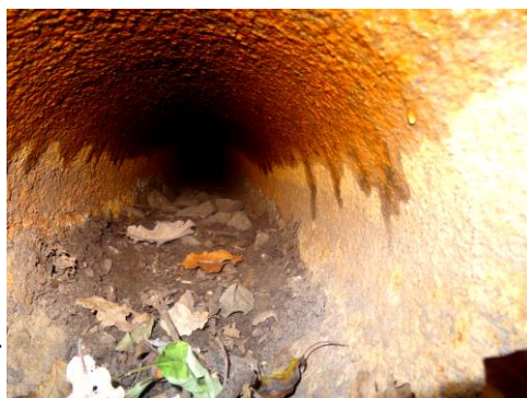
Das Innere vom Rohrdurchlass Km 84,9 (Foto: Koch)
