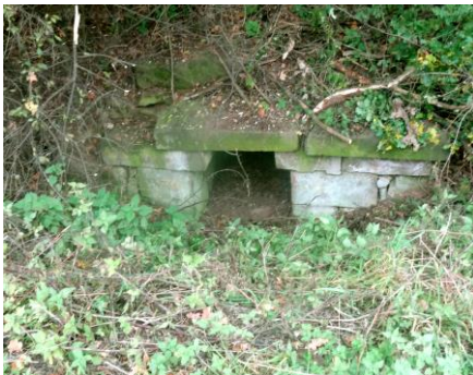
Der Einlauf des Durchlasses bei Km 85,22
