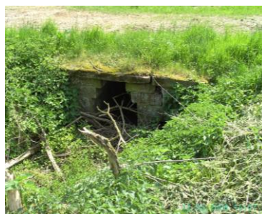
Der abgedeckte alte Einlauf und der Abfluss vom Wasserdurchlass am Bahnübergang Km 84,735
