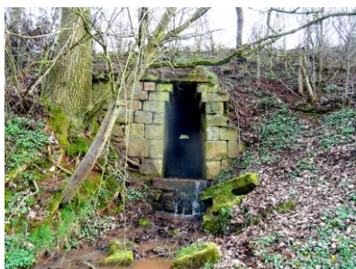
Der Abfluss an der Nordseite des Weges
