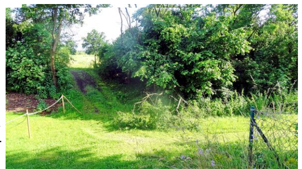
Die alte Zufahrt zum ehemaligen Bahnübergang Km 84,122
