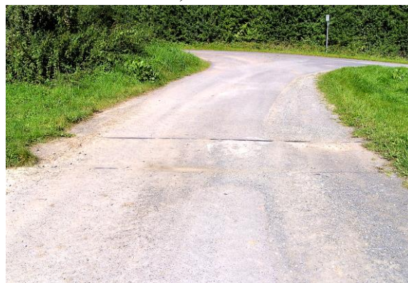
Der Bahnübergang Km 84,735 von Süden am 15. 9. 2007.
