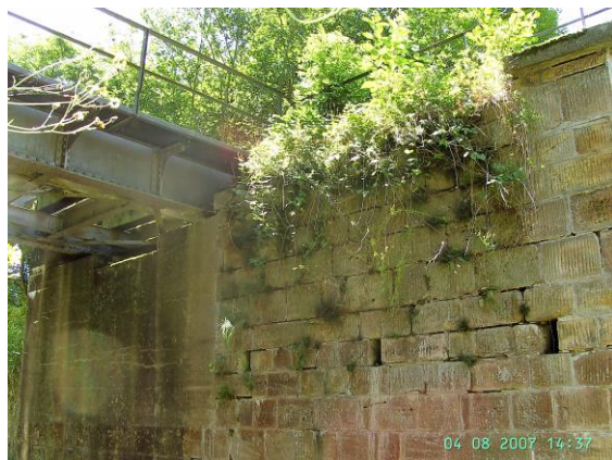
Das westliche Widerlager mit dem ursprünglichen Teil (6. 8. 2007)
