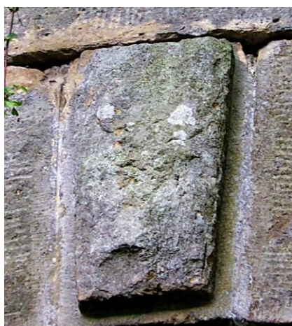
Der Gewölbe-Schlussstein an der Südseite und die Südseite (Bergseite) des gewölbten Durchlasses bei Km 81,46 am 21. 4. 2008.
