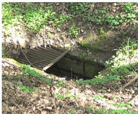
Der Einlauf an der Südseite sowie der Abfluss des Plattendurchlasses an der Nordseite bei Km 82,21. (Beide Fotos v. 1. 5. 2008)
