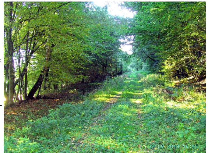
Die stark verkrautete Strecke bei Km 82,3 mit Blick nach Osten am 27. 9. 2013.
