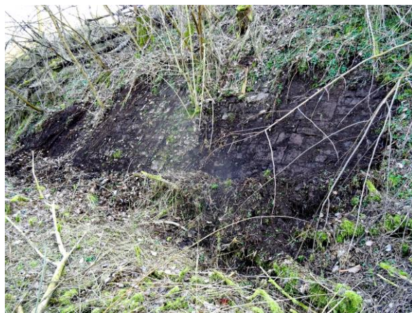
Die teilweise freigelegte Hangsicherung bei Km 83,68 (Foto: Koch im Februar 2016)
