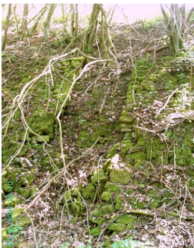
Die Wasserrinne bei Km 81,825 (1. 5. 2008)
