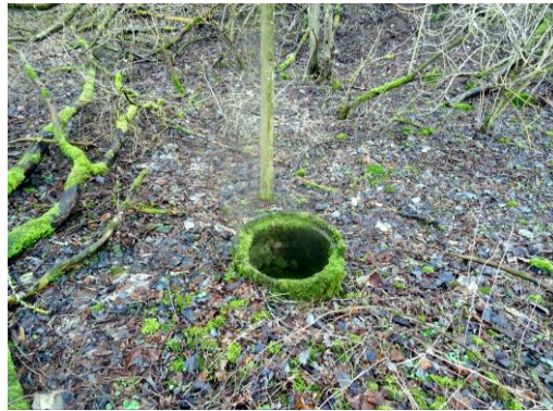
Eine der senkrechten Betonröhren auf der Trasse, in diesem Fall bei Km 81,65.
