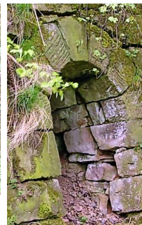
Die Stützmauer auf der Süd-West- Seite mit diversen Buchten, an denen die Steine an den Rundbögen bearbeitet sind.
