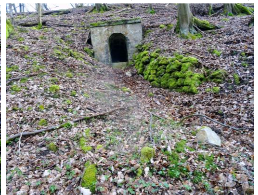
Der nördliche Ausgang des Durchlasses und dessen Lage im Hang mit Bruchsteinen. (Foto: H. Koch, März 2016)
