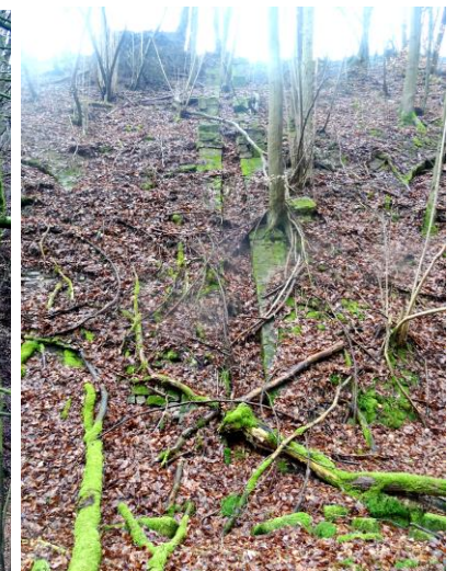
Die ersten Bögen und dazwischen eine Wasser-Abflussrinne etwa bei Km 81,75, die Wasser von oberhalb des Einschnitts den Hang hinunter leitet. (Links Aufnahme von oberhalb des Nordhangs, rechts von der Trasse her) (Fotos: Heinrich Koch)
