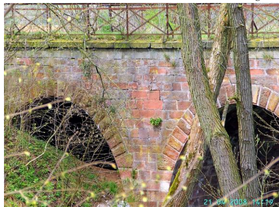
Die zugemauerten Schalllöcher an der Südseite am 21. 04. 2008.
