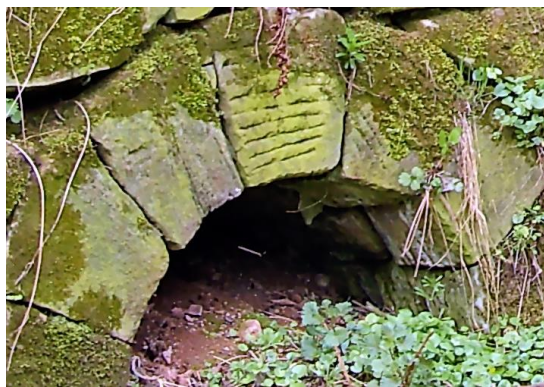
Die Stützmauer auf der Süd-West- Seite mit diversen Buchten, an denen die Steine an den Rundbögen bearbeitet sind.
