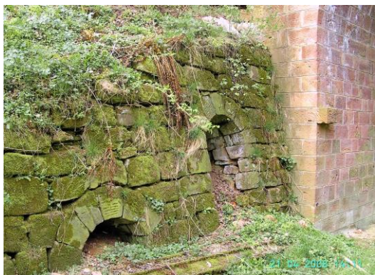
Die Stützmauer auf der Süd-West- Seite mit diversen Buchten, an denen die Steine an den Rundbögen bearbeitet sind.
