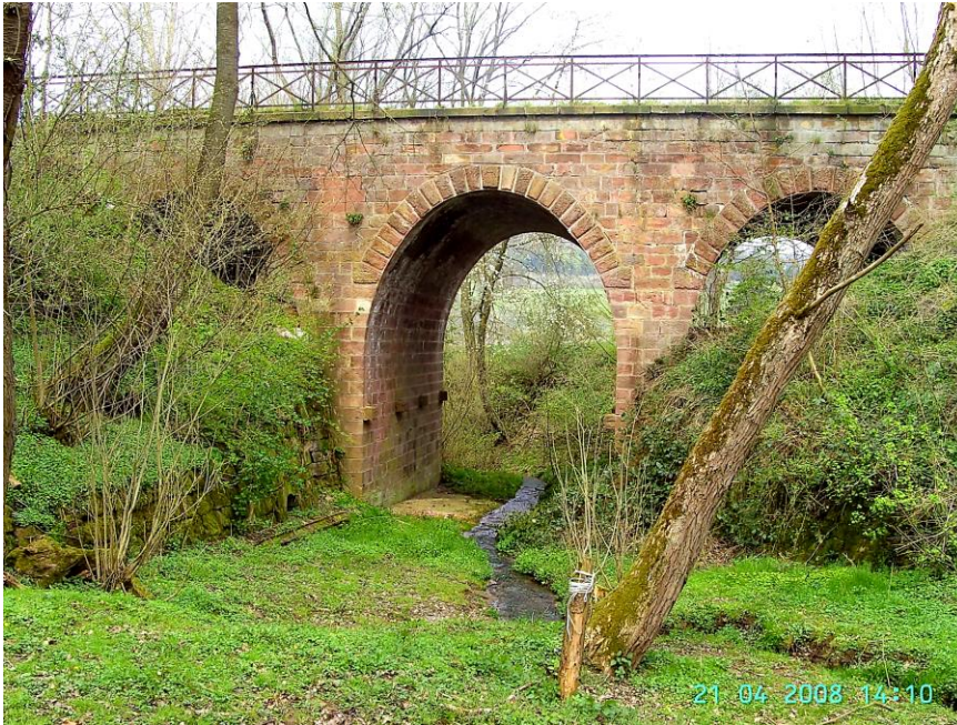
Der Lückgarte-Viadukt bei Km 83,91 am 21. 4. 2008.
