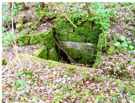
Der Einlauf auf der Südseite bei Km 82,92
