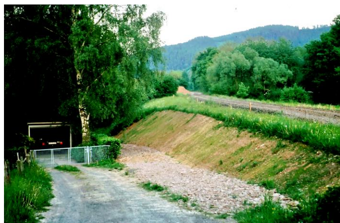
Die im Frühjahr 1990 der Gleise beraubten Bahntrasse unmittelbar vor dem Bahnübergang Km 84,009 in Richtung Lückartebrücke, bei der ein Teil des Bahndamms zu Gunsten einer Zufahrt abgetragen werden musste. (Beide Fotos: Sammlung Reinhard Trumpik)
