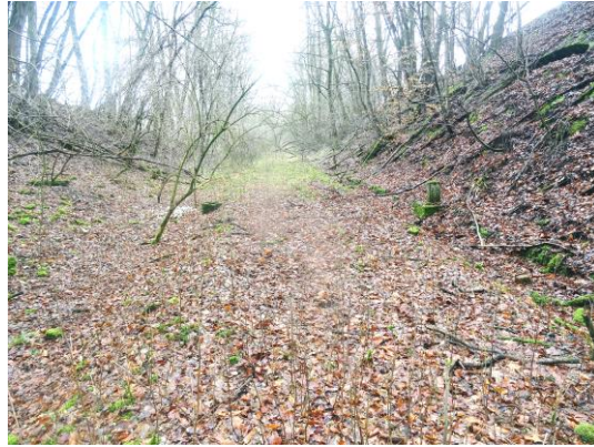
Km 81,72 im Einschnitt mit Kilometerstein 81,7 und Blick nach Osten. Oben rechts ist ein Steinbogen zu sehen.
