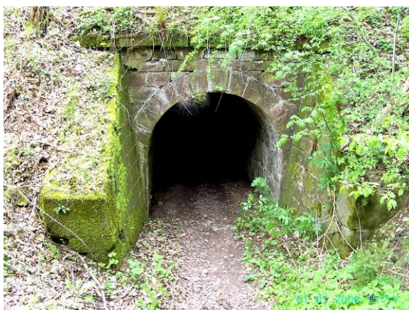
Der Südeingang des Tunnels Km 83,13 mit der wichtigen westlichen Stützmauer am 1. Mai 2008.
