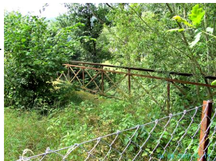
Das ursprüngliche Brückengeländer ist noch erhalten. (Foto vom 4. 8. 2007)
