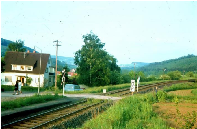
Der Bahnübergang Km 84,009 nach 1974 von der Südseite. (Beide Fotos: Sammlung Heinrich Koch)
