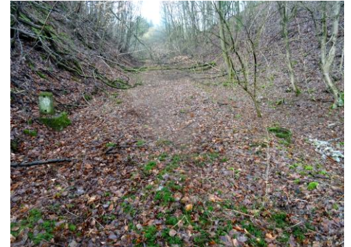
Der Kilometerstein Km 81,7 mit Blick nach Westen mit dem Ende des Einschnitts bei Km 81,8.
