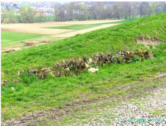
Die etwa 10 m lange Mauer zur Hangsicherung bei Km 81,35
