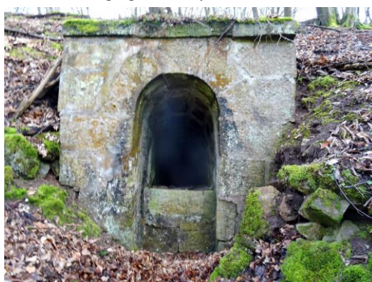
Der nördliche Ausgang des Durchlasses und dessen Lage im Hang mit Bruchsteinen. (Foto: H. Koch, März 2016)
