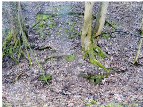
Gemauerte Löcher zur Wasserableitung aus dem Hang. (Beide Fotos oben: Heinrich Koch am 2. 3. 2017)
