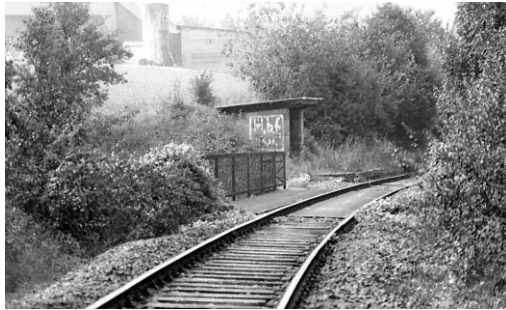
Brücke und Haltepunkt Bergheim, als die Gleise noch lagen. (Foto: Rolf Gießler, Sammlung Reinhold Salzmann)
