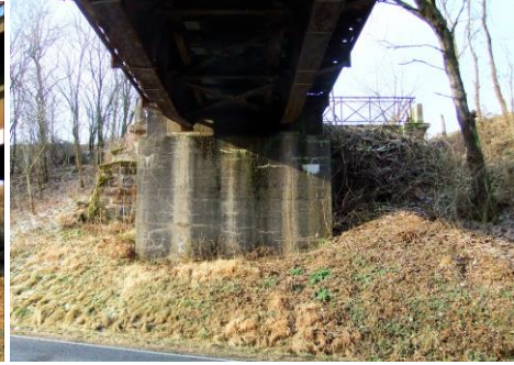
Das neue schmale Widerlager B von vorne mit dem alten Abschlussgeländer an der Nordseite, um 2000)
