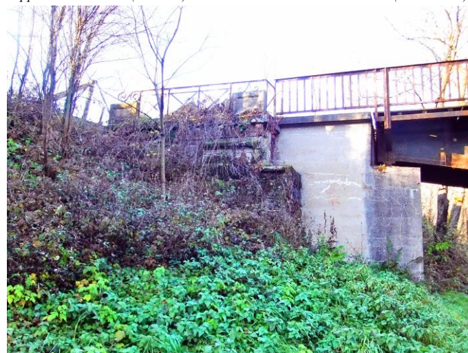
An den Widerlagern (hier westliches Widerlager) blieben die alten Eisengeländer erhalten, wurden aber zur neuen Brücke hin angepasst. (Links 21. April 08) Hier kann man erkennen, dass sich zwischen dem alten und dem neuen Widerlager kein Zwischenraum befindet. (Bild rechts um 2000, Sammlung Trumpik)
