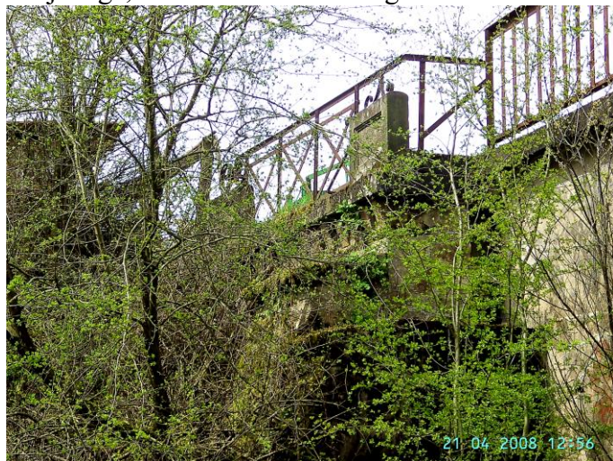
An den Widerlagern (hier westliches Widerlager) blieben die alten Eisengeländer erhalten, wurden aber zur neuen Brücke hin angepasst. (Links 21. April 08) Hier kann man erkennen, dass sich zwischen dem alten und dem neuen Widerlager kein Zwischenraum befindet. (Bild rechts um 2000, Sammlung Trumpik)
