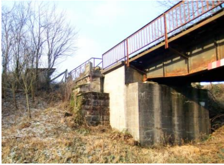
Das Widerlager B (Richtung Malsfeld) mit einem Teil der Stahlkonstruktion um das Jahr 2000. (Foto links und Foto Mitte Sammlung Reinhard Trumpik))
