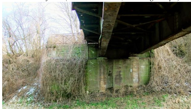
An den Widerlagern (hier westliches Widerlager) blieben die alten Eisengeländer erhalten, wurden aber zur neuen Brücke hin angepasst. (Links 21. April 08) Hier kann man erkennen, dass sich zwischen dem alten und dem neuen Widerlager kein Zwischenraum befindet. (Bild rechts um 2000, Sammlung Trumpik)
