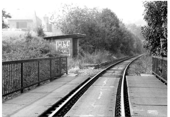
Der Bahnsteig beginnt direkt hinter der Brücke (Foto: Salzmann 1981)
