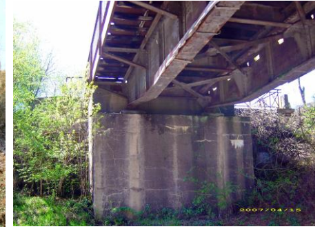
Das schmale Widerlager B mit einem Teil des neuen Überbaus am 15. April 2007.
