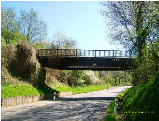
Die Bergheimer Brücke von der Talseite am 15. 4. 2007.
