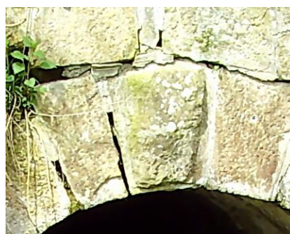
Der südliche Schlussstein vom Wasserdurchlass bei Km 80,92 am 21.4.2008.
