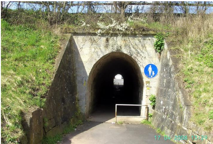
Die Südseite vom Fußgängertunnel bei Km 79,772 am 17. April 2008
