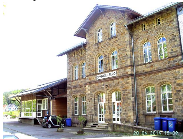
Das Empfangsgebäude von der Straßenseite mit umgebautem Güterschuppen am 20. April 2014.
