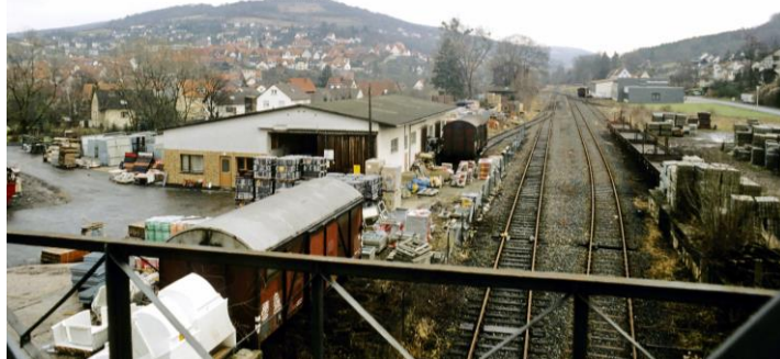
Gleise in Spangenberg um 1985. Nach links zweigt der Anschluss der Firma Assmann Baustoffe ab, rechts ist die Laderampe zu sehen. (Foto: Reinhold Salzmann)
