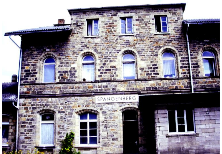
Die Gleisseite vom Empfangsgebäude mit ausgebauter Dachgaube.
