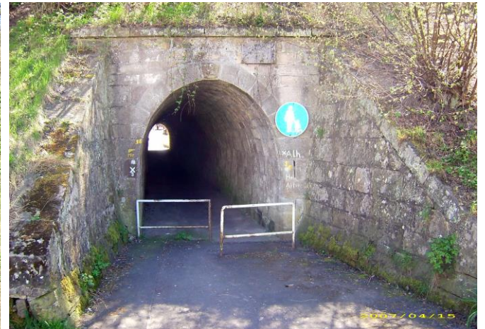
und die Nordseite des Tunnels am 15. April 2007
