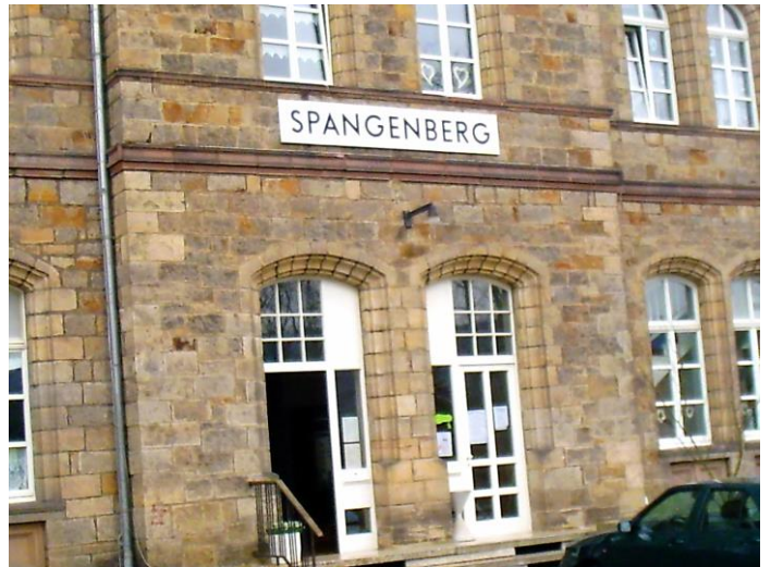
Die beiden großen Eingangstüren vom Empfangsgebäude am 9. Februar 2006.
