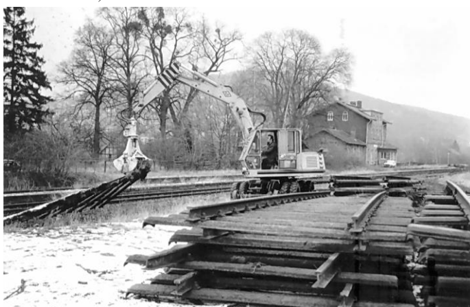
Während des Gleis-Abbaus türmen sich im Januar 1990 die Gleisjoche am Spangenberg Bahnhof. (Foto: Reinhold Salzmann)
