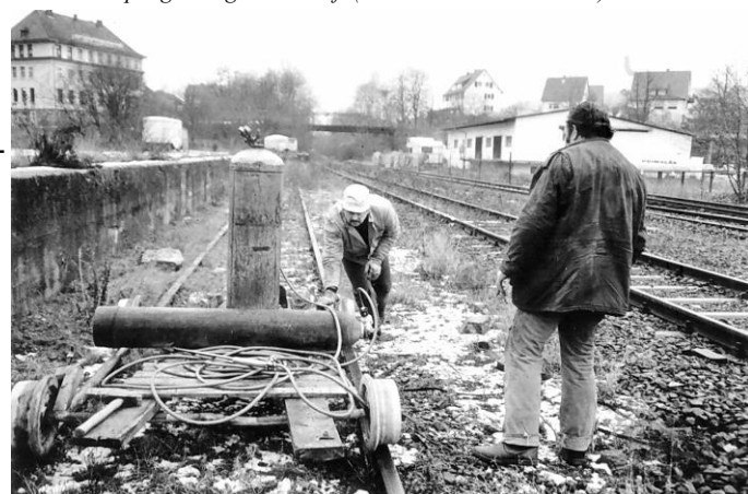
Im Januar 1990 begann der Gleisabbau am Spangenberg Bahnhof. (Foto: Reinhold Salzmann)
