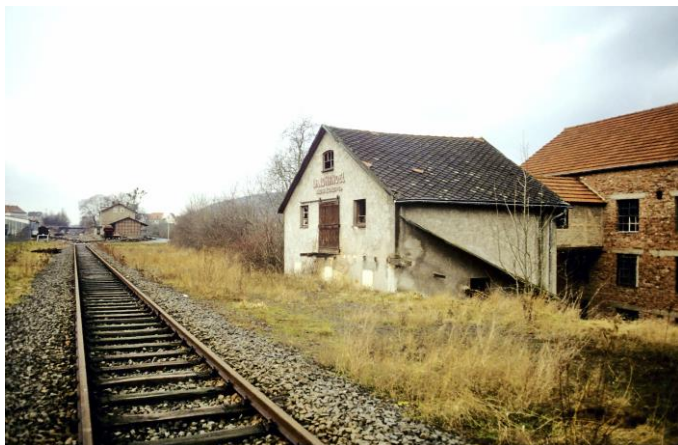
Die schon zurück gebauten Gleise am Bahnhof aus Richtung Beieröde zeigen die Demontage in den 80-er Jahren.
