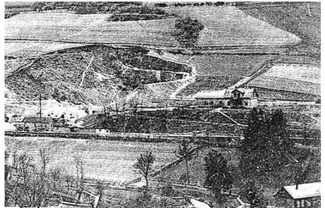
Der Steinbruch Geldmacher mit Verladestation.
