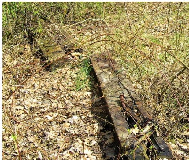
Die liegen gebliebenen Schwellen bei Km 78,35 am 17. 04. 2008.
