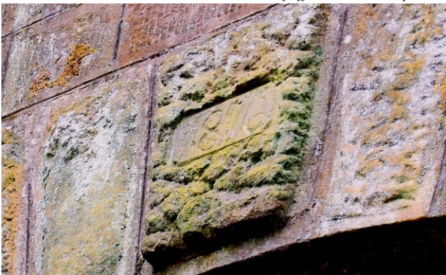
Die Jahreszahl 1876 im Schlussstein des Gewölbebogens der Pfeiffe-Flutbrücke von der Nordseite am 09. April 2007.
