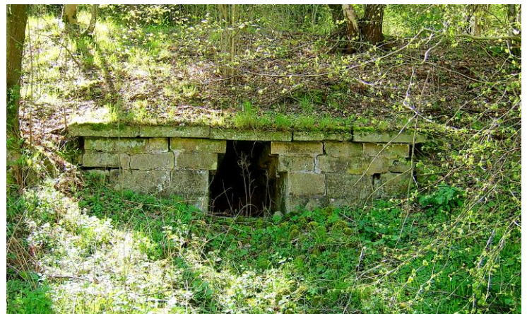
Der treppenförmige Plattendurchlass vom Km 79,36 am 15. April 2007.
