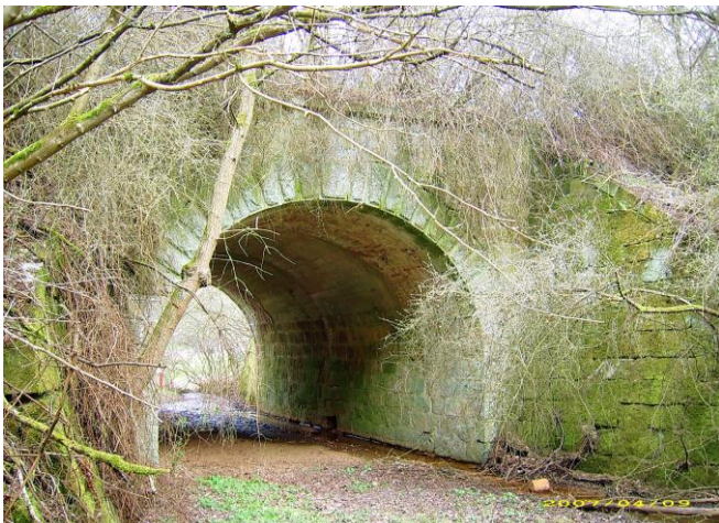
Das Gewölbe der Pfeiffebrücke von der Südseite am 9. April 2007.
