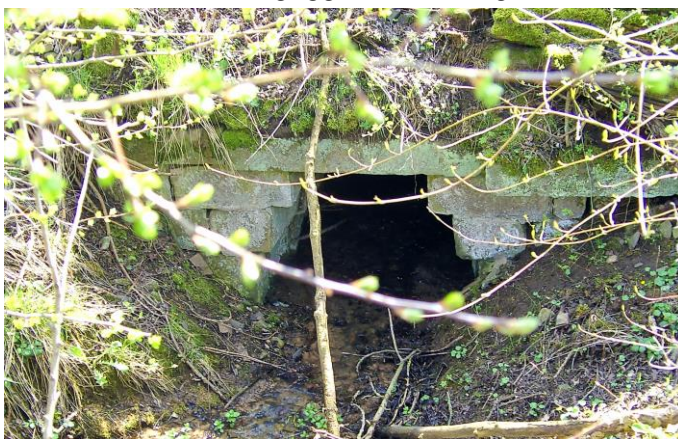
Der Wasserdurchlass am Km 78,252 am 17. April 2008.
