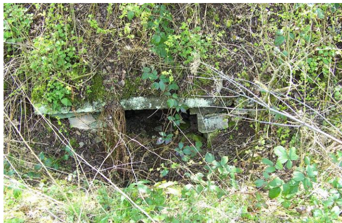
Der Wasserdurchlass von Km 77,58 am 17. April 2008.
