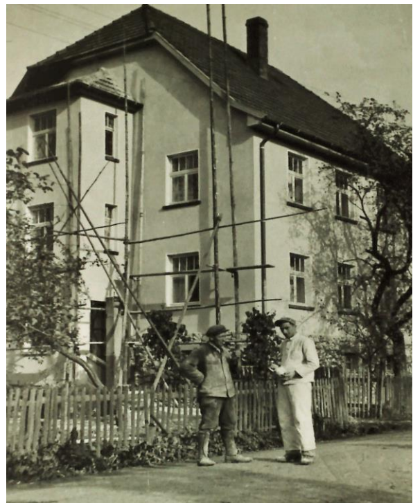
Gerüstaufbau zum Verputzen des Hauses Steinbrecher (Fischer) in Ostheim
