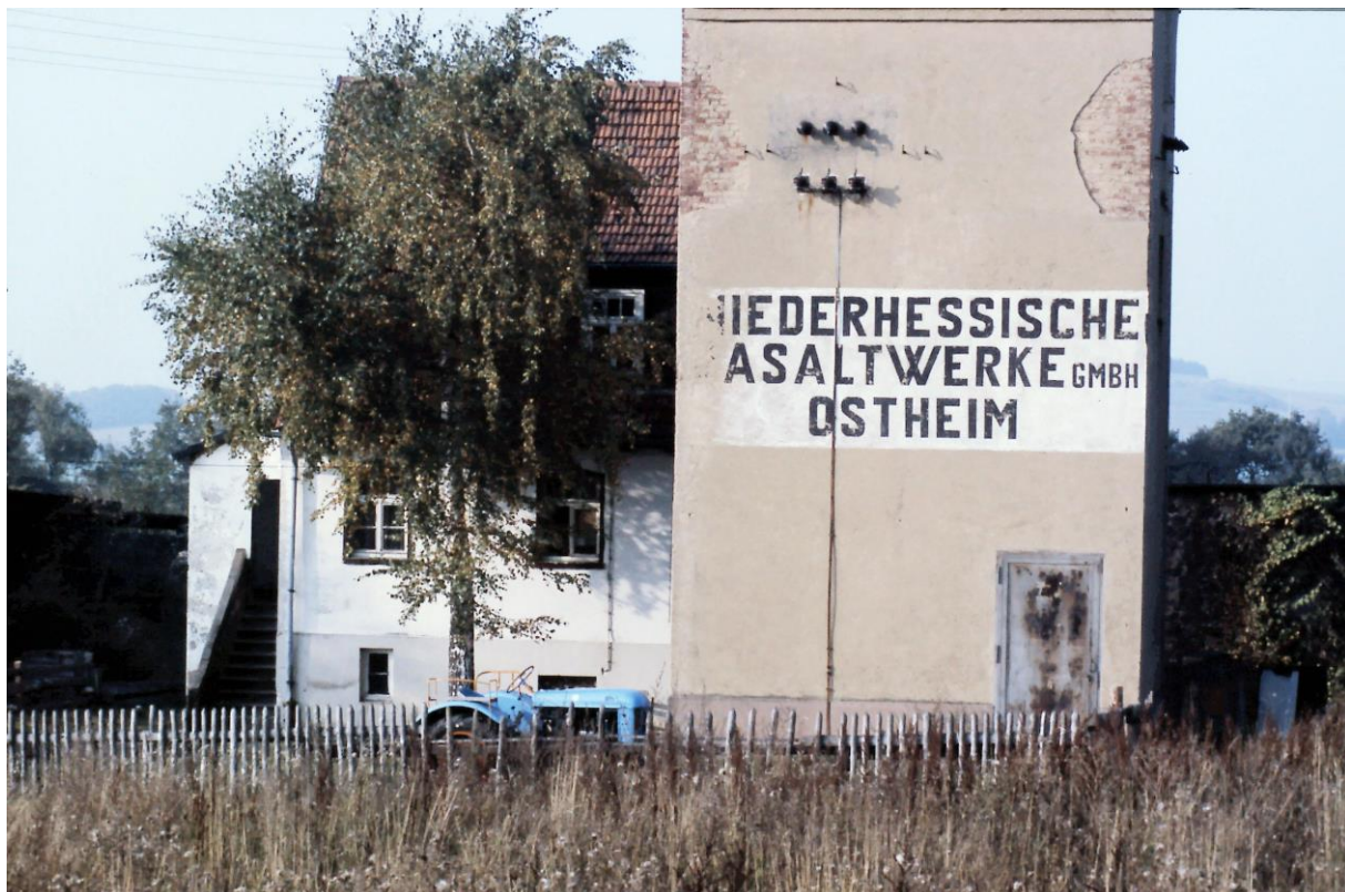
Basaltwerk („Kloppmaschine“) mit Wohnungen für beim Basaltwerk Beschäftigte
