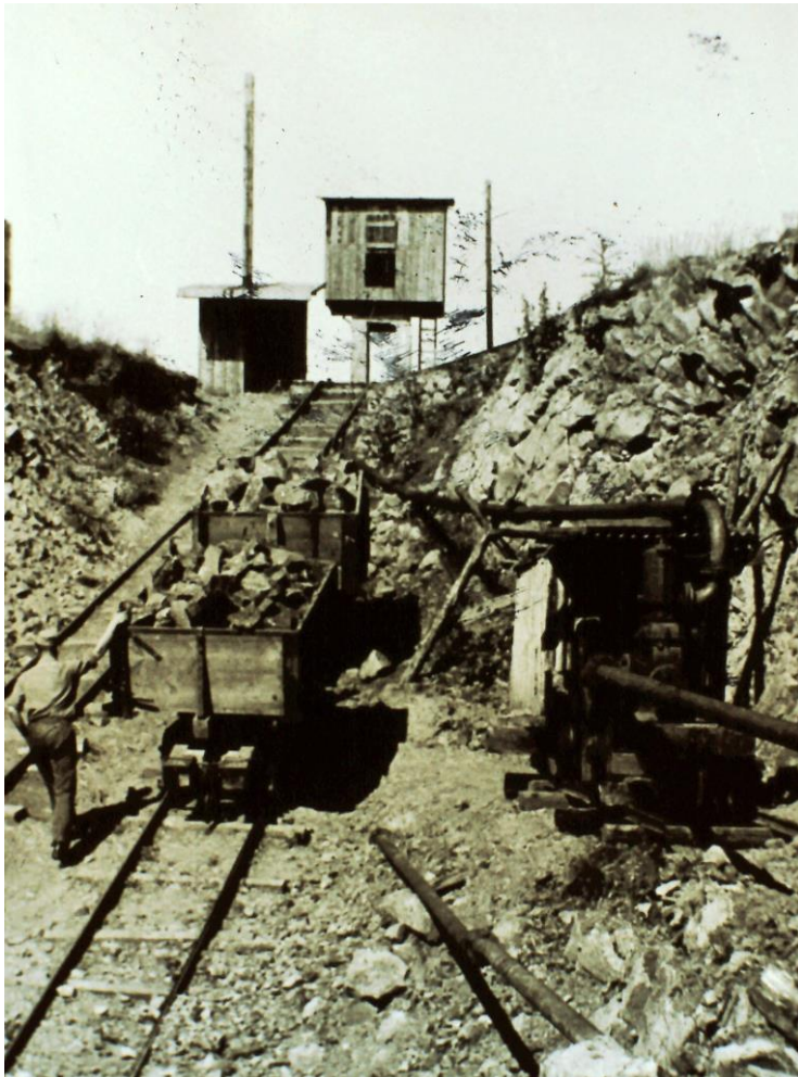
Drahtseilschrägaufzug aus dem Hessenland
