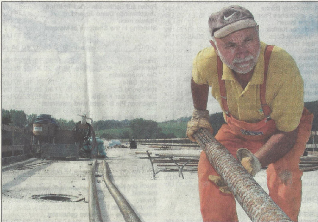
Auf der Brücke: Die Arbeiten am Autobahnzubringer, der über die Fulda führt, gehen zügig voran. Hier bewegt Dieter aus dem Bruch ein Stahlteil.
