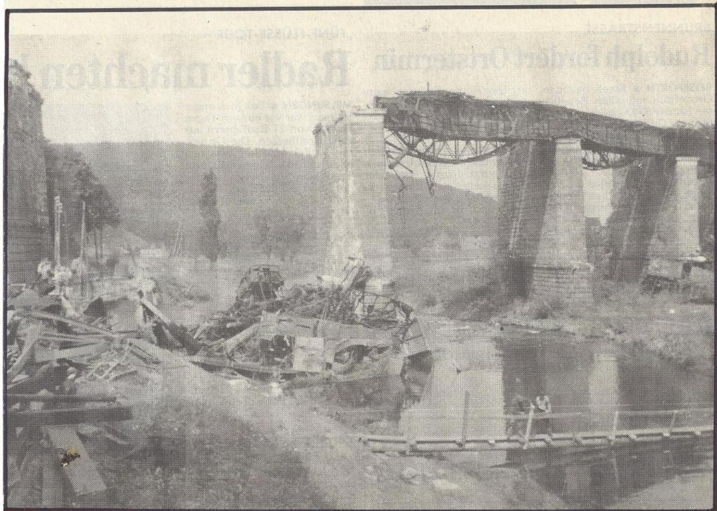
Ein seltenes Bild aus einer Zeit, in der fotografieren streng verboten war: Die Bahnbrücke über die Fulda zwischen Malsfeld nach ihrer Zerstörung durch einen entgleisten Güterzug am 24. März 1945. Ladung und zerstörte Waggons liegen noch im Fluß, der von einem hölzernen Notsteg überspannt wird. (Fotos: Mihm)
