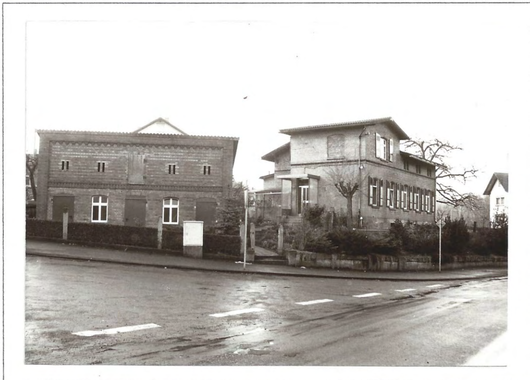
Bahnmeisterei und Nebengebäude
