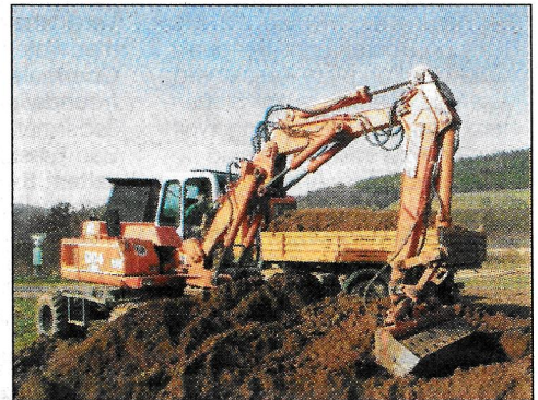
Erde für den Friedhof: Mitarbeiter des Malsfelder Bauhofs holten Aushub von der Baustelle. FOTOS: LACHE-ELSEN/ZAL
