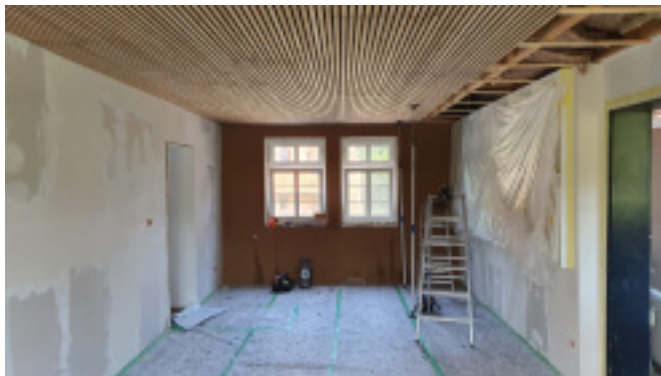
Der kleine Saal kurz vor der Fertigstellung.
