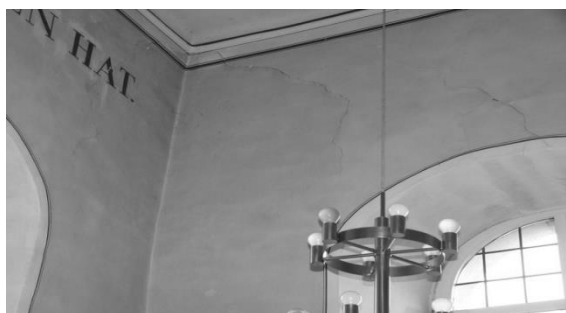
▲ Faulende Balken unter dem Glockenturm Risse in den Wänden des Kirchenschiffes ▼
