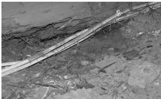
▲ Faulende Balken unter dem Glockenturm Risse in den Wänden des Kirchenschiffes ▼
