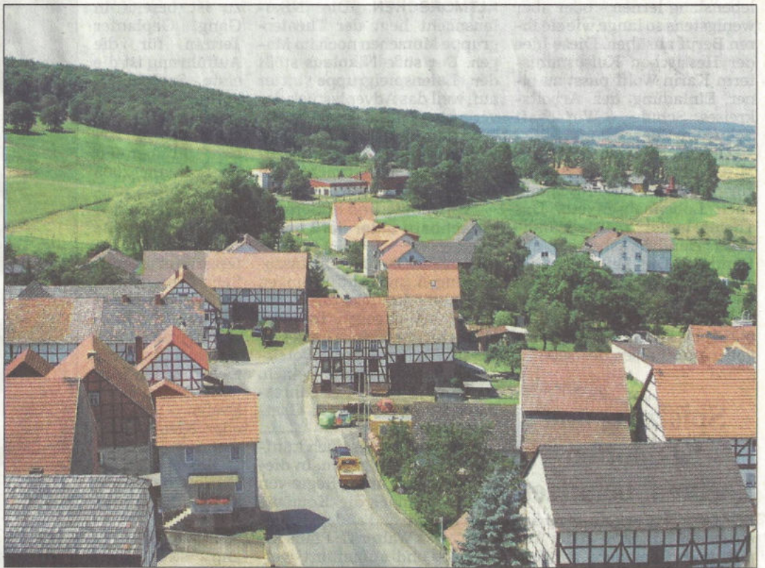
Idylle von oben: Viel Fachwerk sieht man beim Blick vom Kirchturm auf Dagobertshausen.
