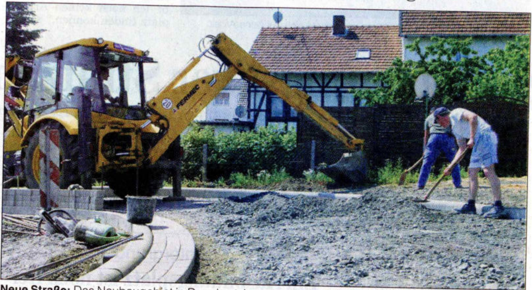
Neue Straße: Das Neubaugebiet in Dagobertshausen wird angeschlossen. Rechts: Dimitri Maximow und Klaus Weix von der Firma Franke bei der Arbeit.
