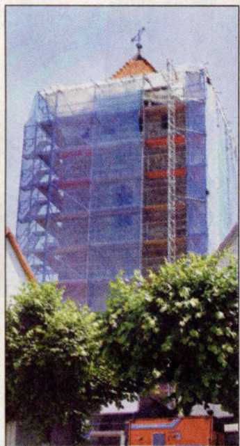
Blau in Blau: Der Kirchturm in Dagobertshausen ist eingerüstet.
