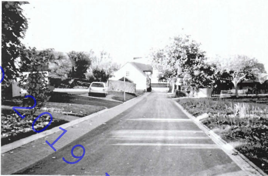
Die fertig ausgebaute Straße „Zum Hügelkopf“, Höhe Haus Hofmann/Fröhlich. Diese Straße hatte die Neubearbeitung nötig. Hier war alles marode. Die Zeit hatte am Zustand besonders Spuren hinterlassen.
