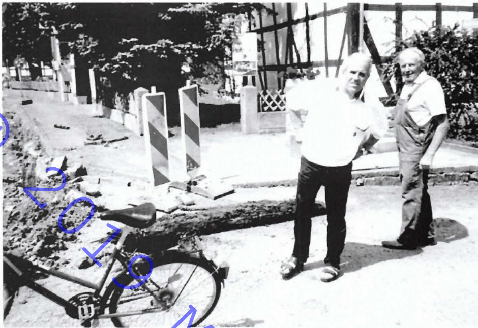
Durch den Bagger aus dem Erdreich gehoben: Eine ca. 180 Jahre alte Wasserleitung aus Holz: H. Kellner nahm sie in sein Museum auf (siehe hinter K. Ploch liegend.)
