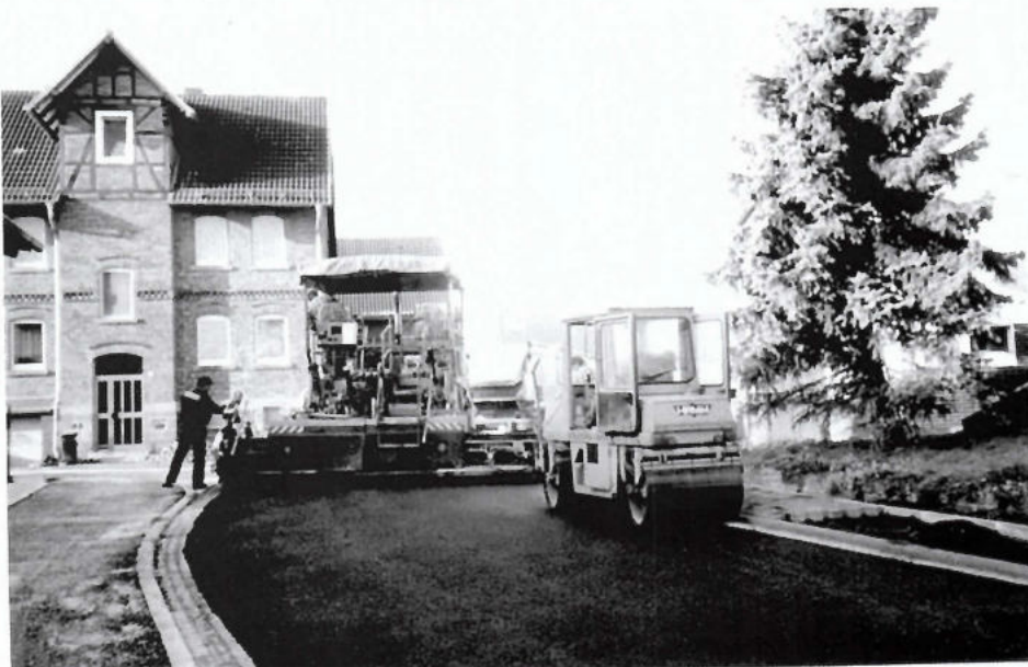
Der Deckenfertiger oder Teermaschine im Einsatz.
