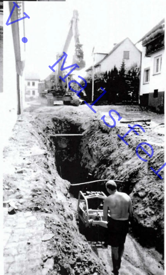
Rechts: Ein Foto über das Ausmaß der Kanalisationsarbeiten in der Straße „Hornberger Weg“ vor den Anwesen Grunewald und Stegemann. Ein Arbeiter der Firma Franke verdichtet mit Sand die in 3,80 Meter Tiefe gelegten dicken Rohre.
