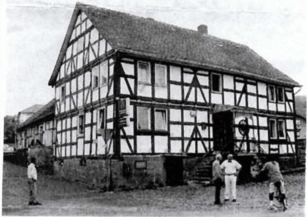
Muß von außen dringend gemacht werden. Das solle auch geschehen, hieß es von seiten des Verwalters.
