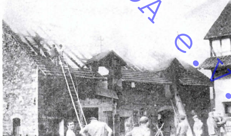
DICKE RAUCHWOLKEN lagen auch am Freitagabend noch über der Gemeinde Dagobertshausen, wo — wie gemeldet — zwei Blitze kurz hintereinander in das Stallgebäude des Landwirts Kothe eingeschlagen hatte. Da die gesamten Heuvorräte auf dem Boden des Stallgebäudes (unser Bild) lagerten, hat Kothe jetzt große Sorgen, wie er seine 35 Stück Großvieh durchbringen soll. Obwohl auch die anderen Bauern keinen Ueberschuß an Heu haben, erklärten einige von ihnen noch während des Brandes, daß Kothe auf sie rechnen könne. (e Aufnahme: e)
