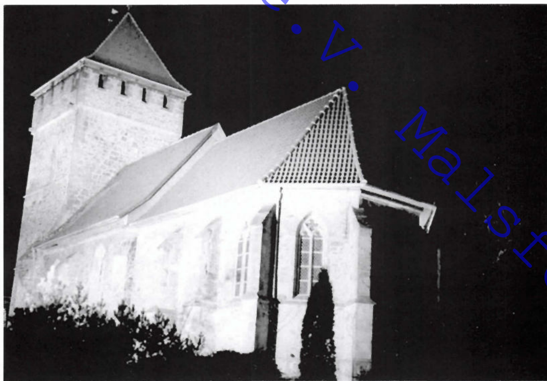
Die gleiche Einstellung bei Nacht. Am 10. Juli 1985 wurde die Flutlichtanlage eingeweiht. Aufgrund einer Initiative vom Ortsbeirat konnte diese Maßnahme verwirklicht werden.
