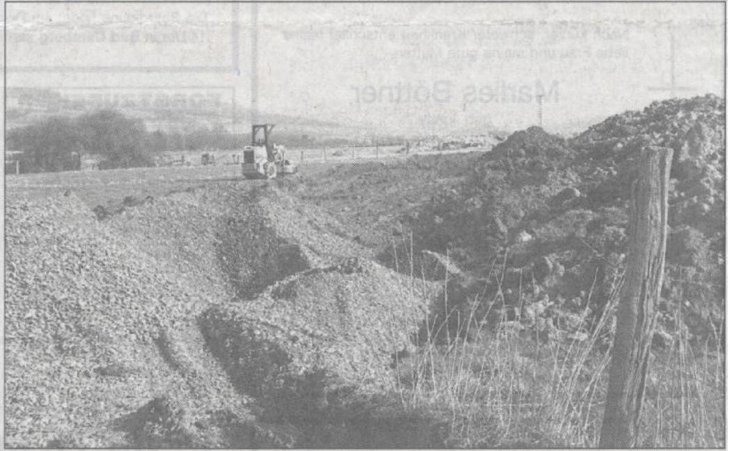
Kleiner Bagger auf weiter Flur bei Dagobertshausen. Hier wird zur Zeit der Hauptsammler gelegt. (Foto: Sangerhausen)
